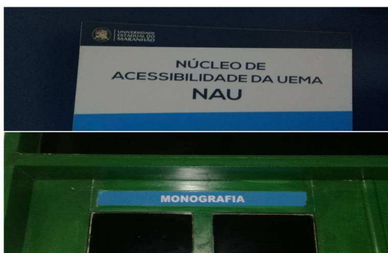
Figura 11 – Placas de acesso à sala da UEMA sem sinalização tátil
