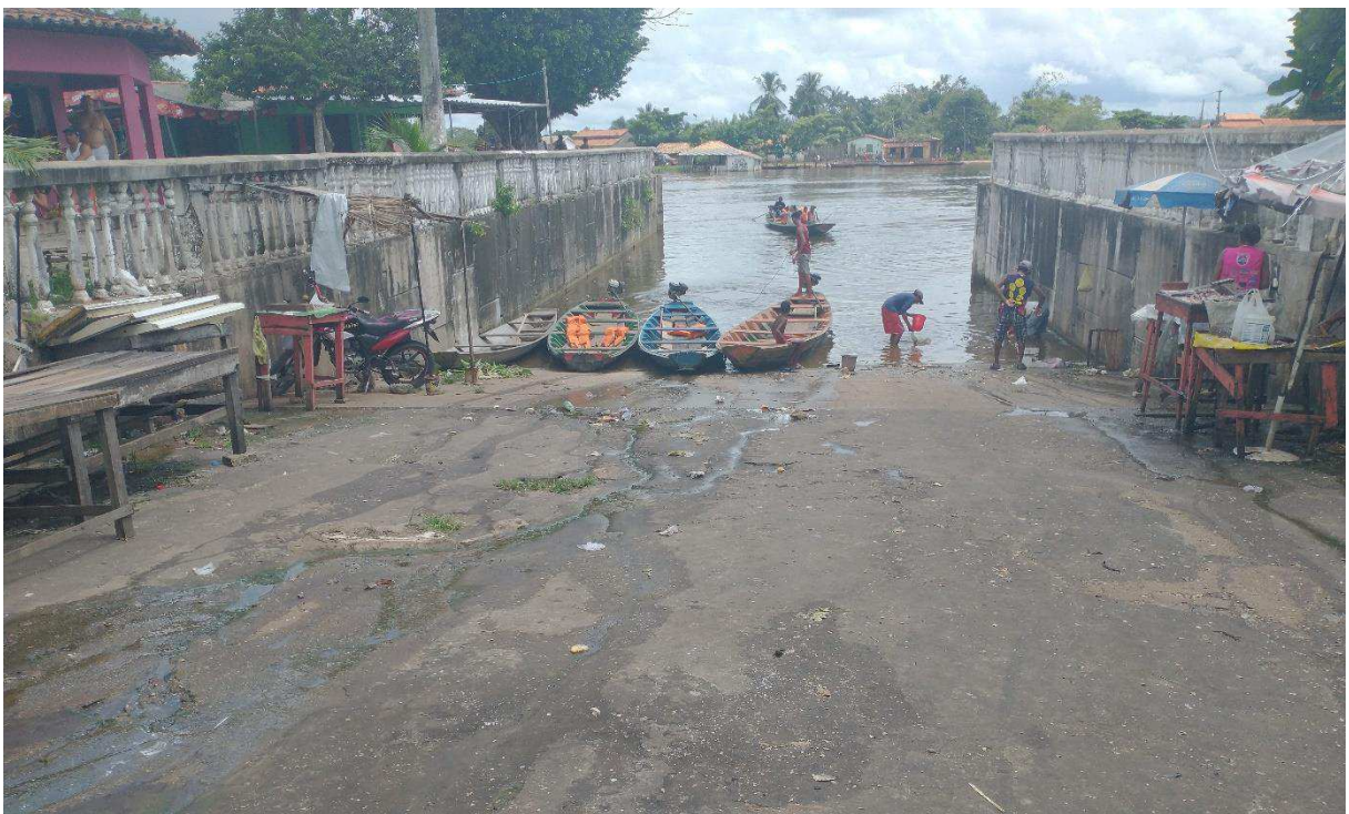
Figura 68. Vista da Rampa.
