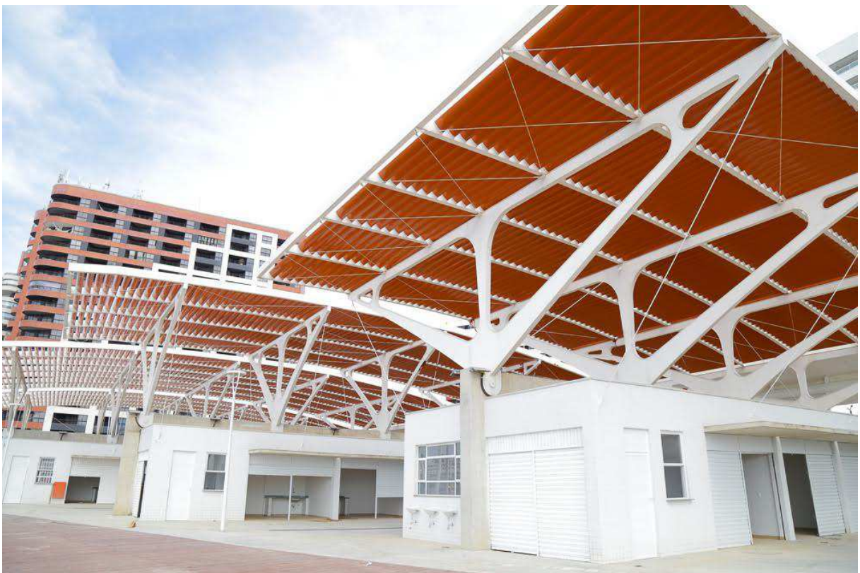
Figura 47. Detalhe das tesouras metálicas da cobertura.
