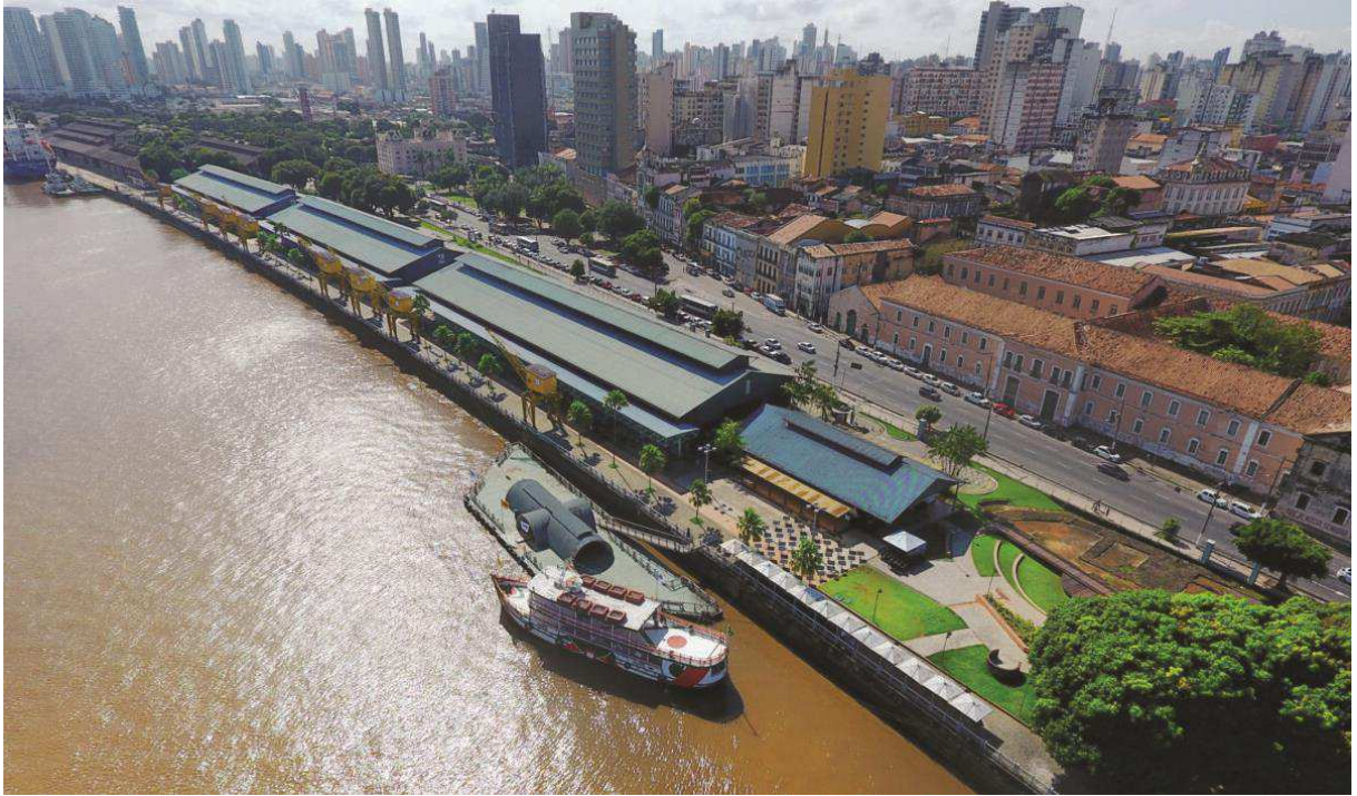
Figura 36. Estação das Docas, Belém, Pará.
