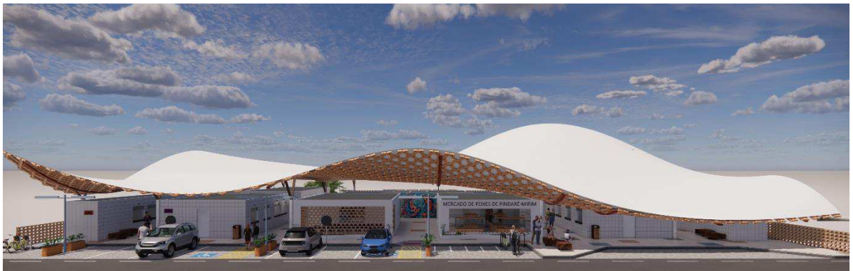
Figura 77. Fachada frontal com destaque para cobertura.
