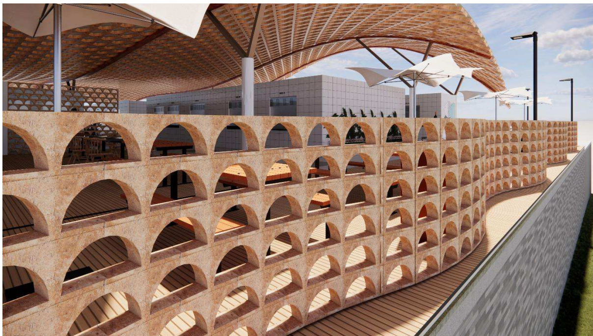
Figura 83. Guarda-corpo curvo de cobogó.
