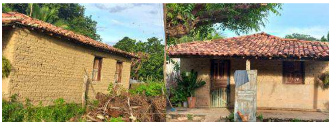
Figura 27 - Imagens de moradia construída com adobe no município de Magalhães de Almeida (MA)
