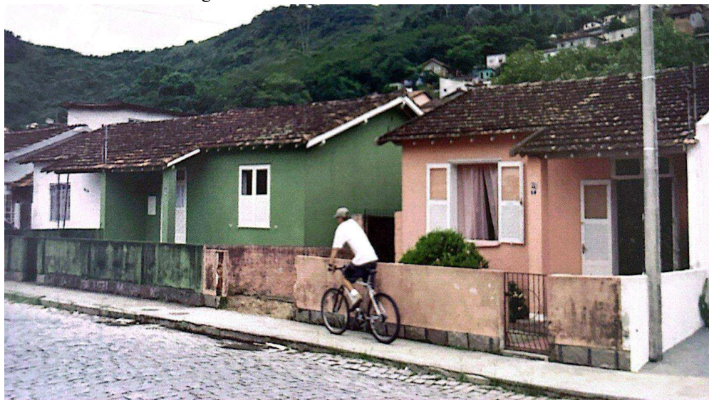
Figura 3 - Fachada das unidades habitacionais
