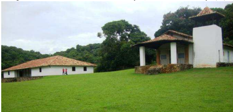
Figura 12 - Casa do Sítio de Santo Antônio e capela, localizada em São Roque (SP)
