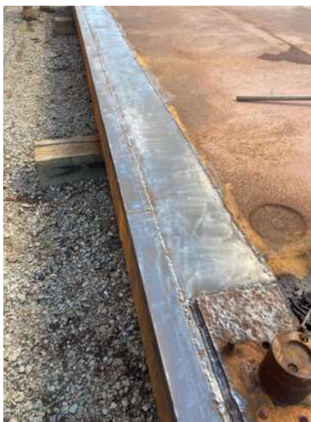
Figura 3.14 – Lixamento das estruturas metálicas das pedras da balança. Fonte: Autor (2021).
