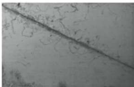
Figura 2.9: Corrosão Filiforme (GENTIL, 2011)
