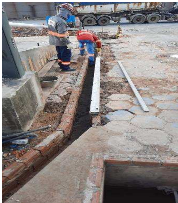
Figura 3.16 – Execução de sistema de drenagem na balança nº 1. Fonte: Autor (2021).
