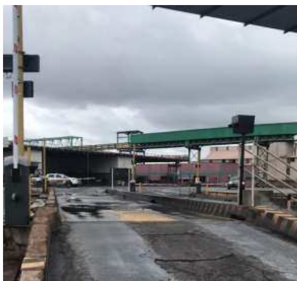
Figura 3.9 – Balança Rodoviária nº 1 da Área Primária do Porto do Itaqui antes da parada programada geral. Fonte: Autor (2021).
