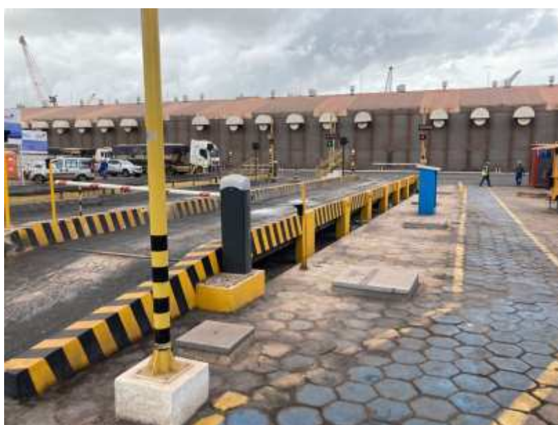
Figura 4.2 – Balança rodoviária após recuperação. Fonte: Autor (2021)
