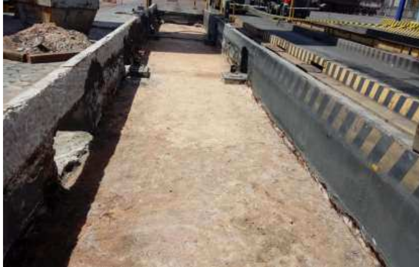
Figura 3.4 – Piso da balança n° 1 após retirada das pedras e limpeza. Fonte: Autor (2021).
