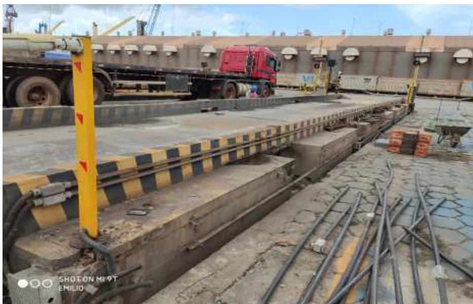
Figura 3.3 – Balança Rodoviária nº 1 apresentando dificuldade de acesso inferior. Fonte: Autor (2021).
