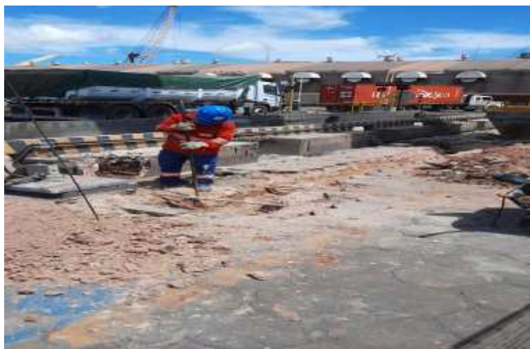
Figura 3.15 – Demolição de piso para embutimento de instalações elétricas. Fonte: Autor (2021).
