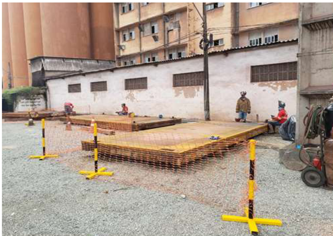
Figura 3.13 – Lixamento das estruturas metálicas das pedras da balança. Fonte: Autor (2021).
