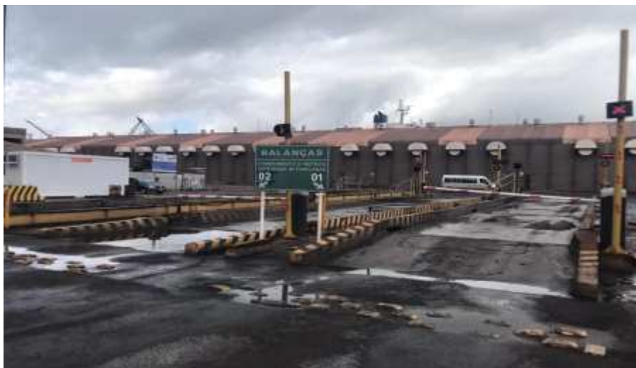
Figura 3.8 – Balanças Rodoviárias da Área Primária do Porto do Itaqui antes das reformas. Fonte: Autor (2021).
