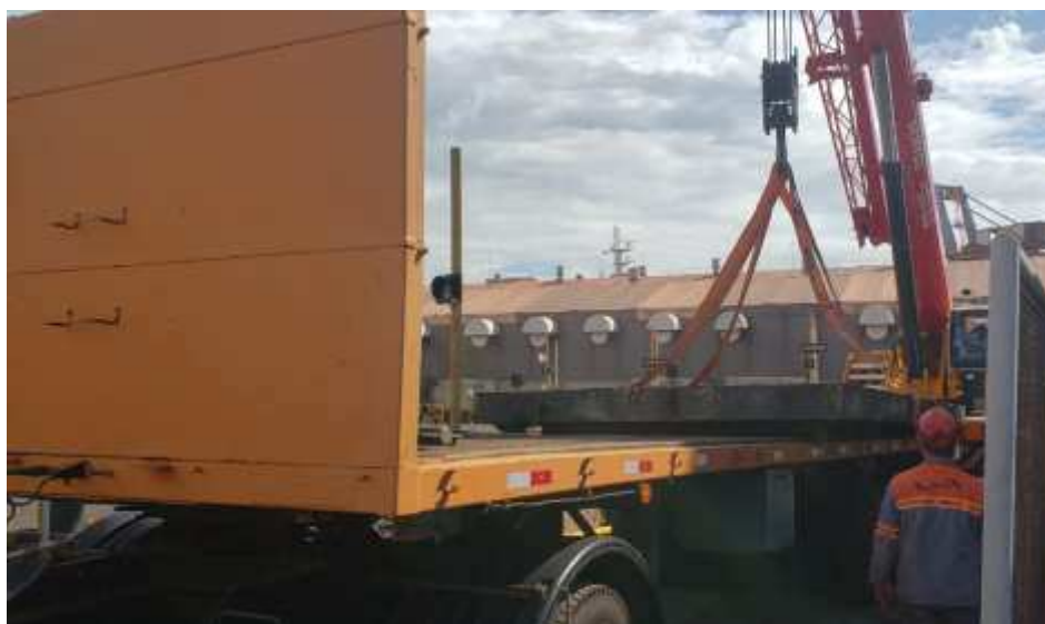
Figura 3.11 – Içamento de pedra da balança. Fonte: Autor (2021).
