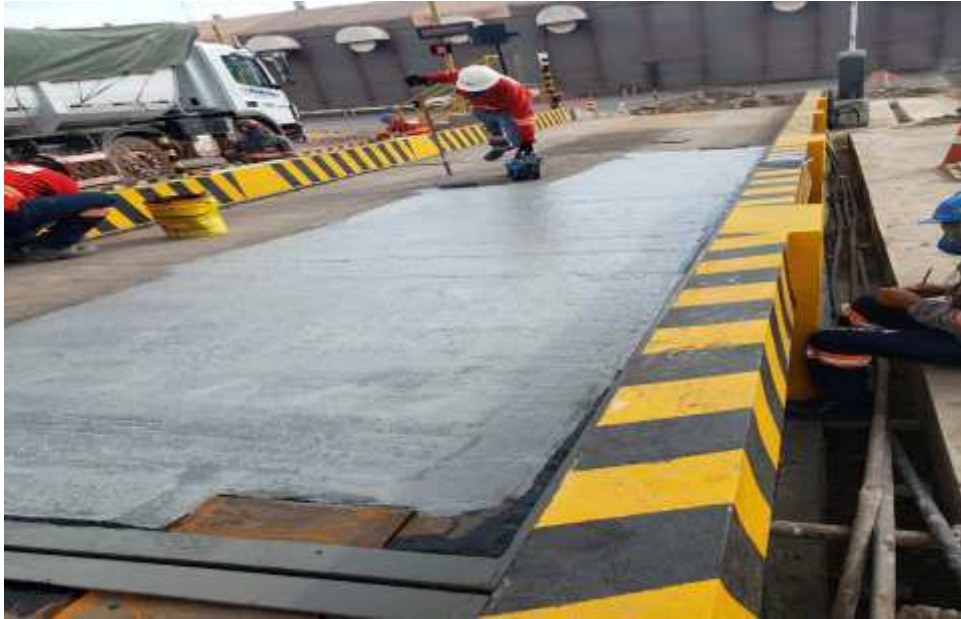
Figura 3.17 – Pintura da Balança Rodoviária nº 1. Fonte: Autor (2021)
