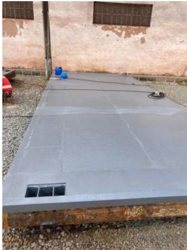
Figura 3.18 – Pintura da Balança Rodoviária nº 1. Fonte: Autor (2021)
