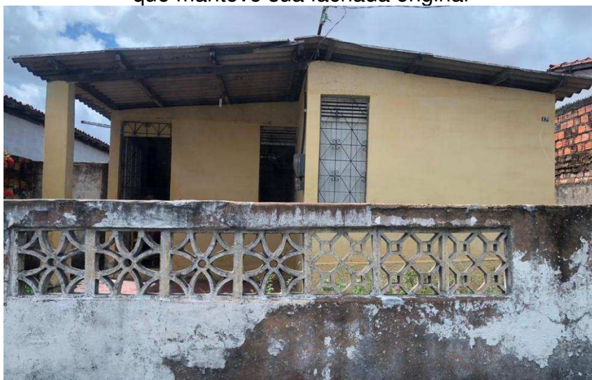
Figura 32 – Unidade habitacional do Cohab-Anil III com tipologia MA-C-2-43 que manteve sua fachada original
