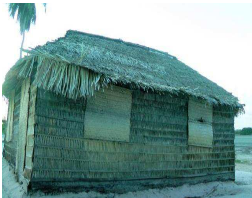
Figura 05 - Padrões de Edificação: Palha
