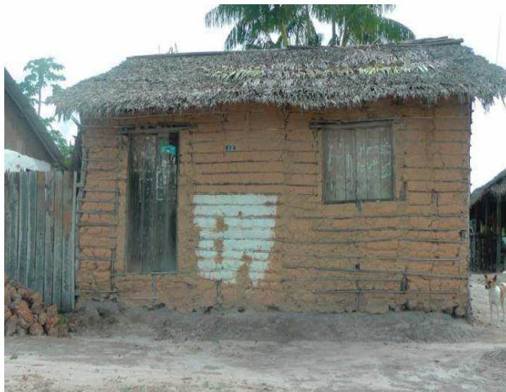
Figura 06 - Padrões de Edificação: Taipa-de-mão
