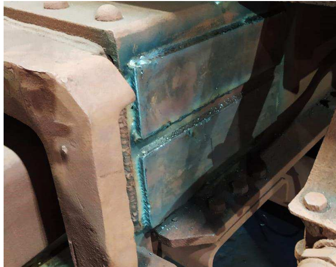
Figura 6.18 – Modelo experimental instalado para testes em campo (Autor, 2021)
