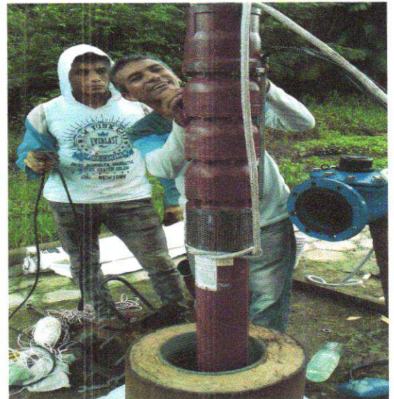
Figura 4- Descida da tubulação
