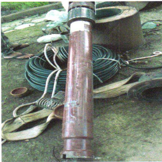
Figura 5- Preparação para a descida da tubulação
