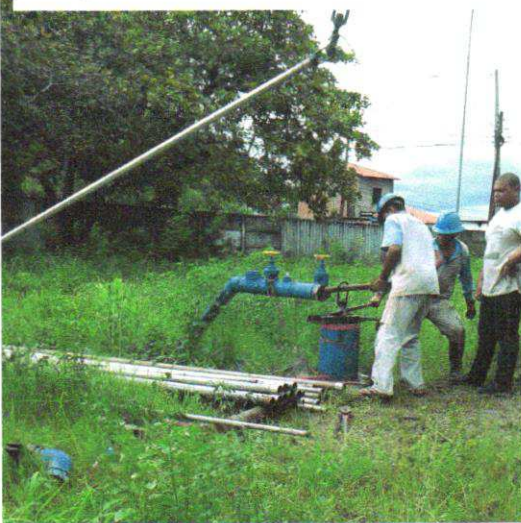
Figura 2- Retirada da tubulação.
