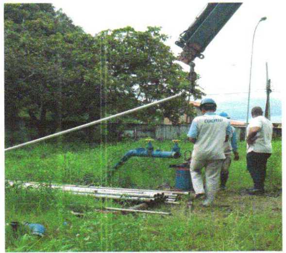
Figura 3- Após a retirada da tubulação
