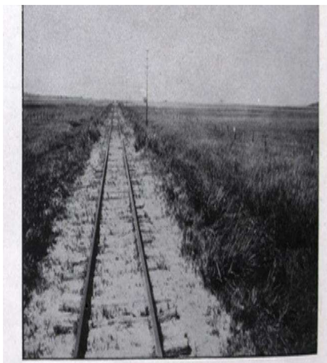
Figura 39 – Linha férrea São Luís-Teresina no Campo de Perizes na década de 1950
