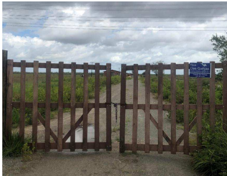
Figura 17 – Portão com cadeado na Rua das Garças
