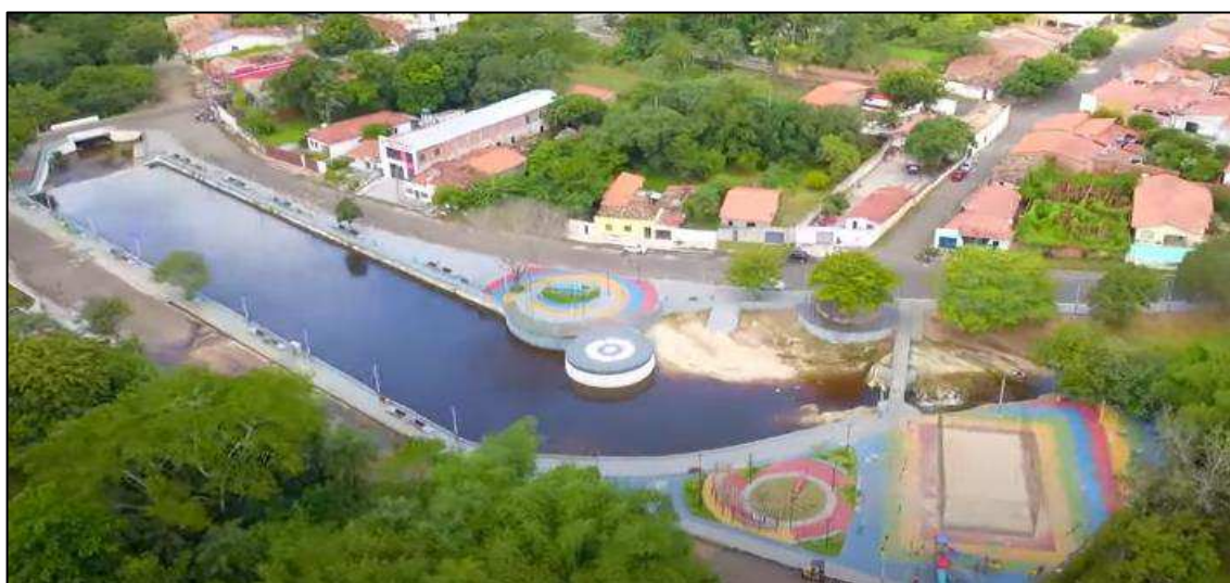
Figura 8 - Piscina do Ponte reformada
