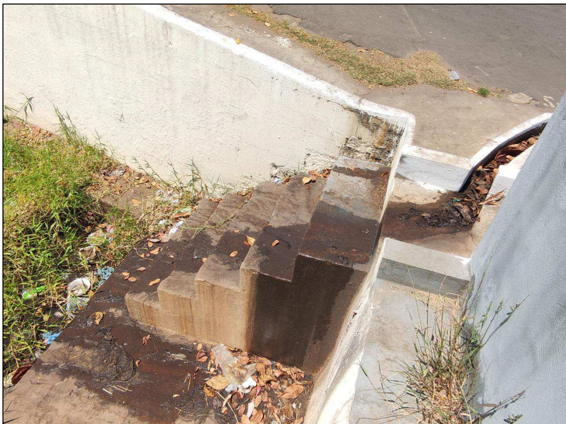
Figura 12 – Sarjetas direcionadas para a piscina
