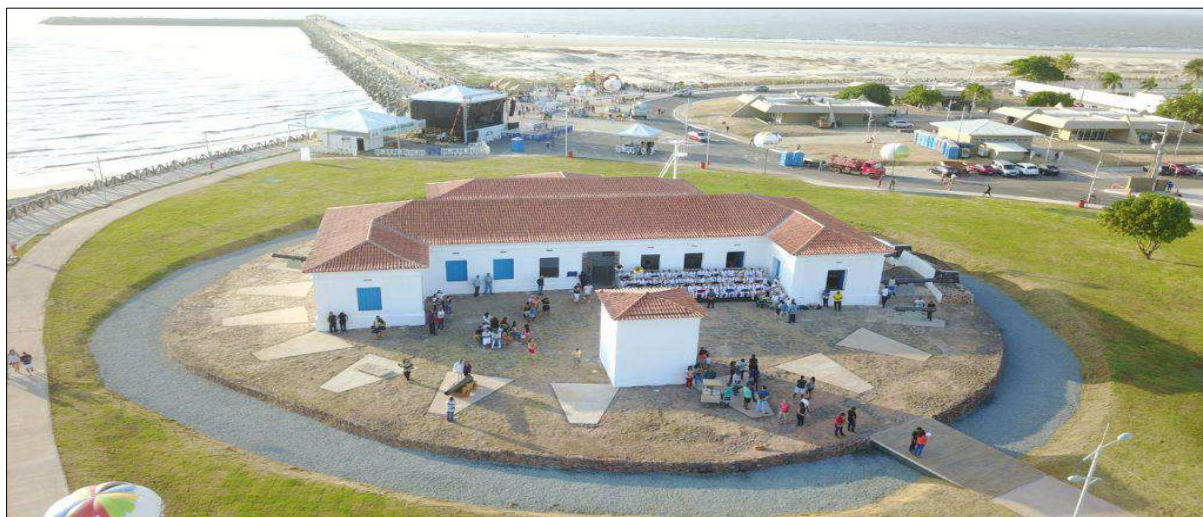
Figura 05 - O Forte de Santo Antônio da Barra depois de reformado
