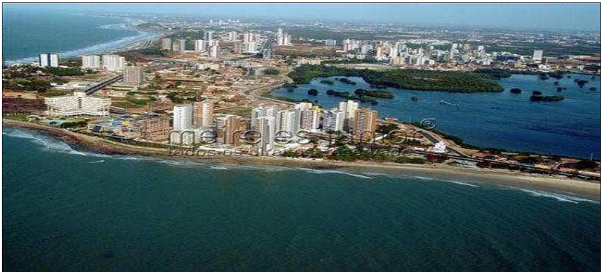
Figura 09 - Parte do bairro Ponta d'Areia em meados dos anos 2000
