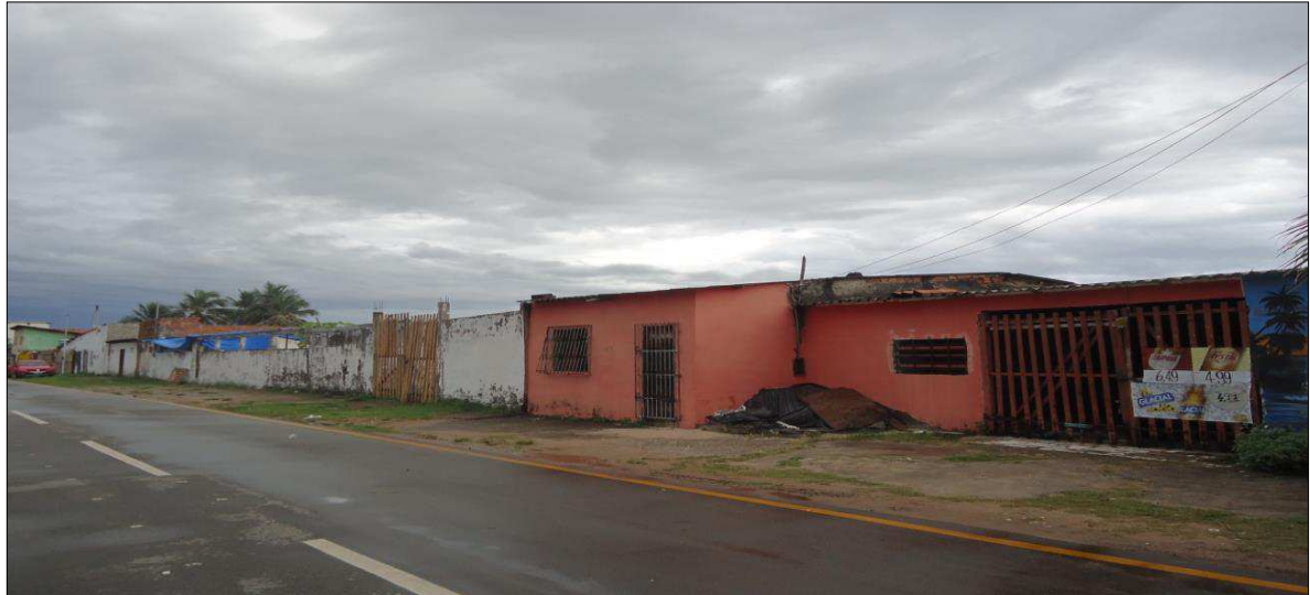
Figura 10 - Moradias no bairro Ponta d'Areia: Rua Ivan Loureiro
