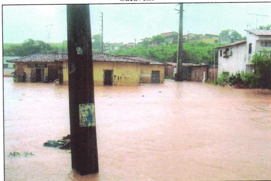
Figura 13 - Área inundada no trecho de montante do Canal do Rio das Bicas, Salinas Sacavém
