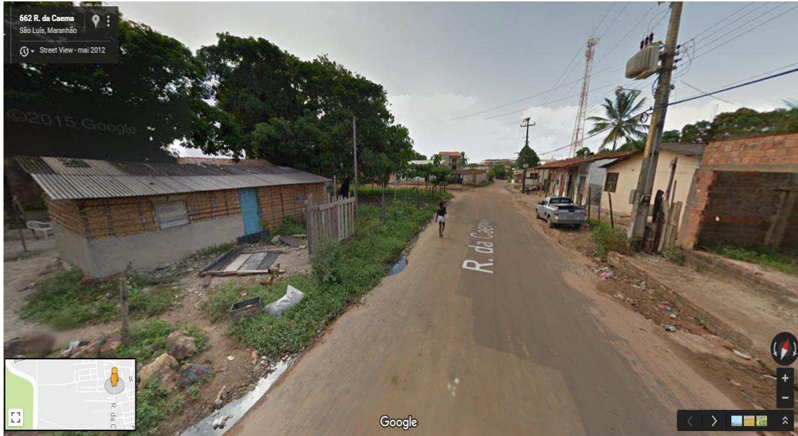
Figura 8 – “Rua da Caema”, no bairro da Vila Conceição, localizado nas áreas de vulnerabilidade do Rio Calhau
