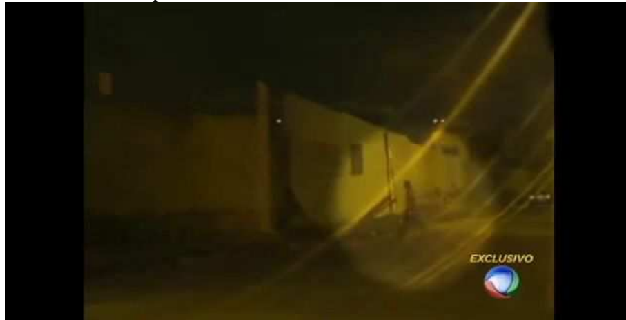
Figura 1 – Reportagem exclusiva sobre as condições estruturais do Complexo de Pedrinhas
