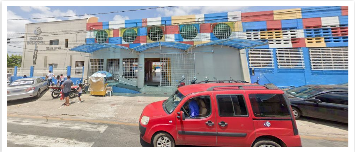
Figura 1 – Fachada da escola
