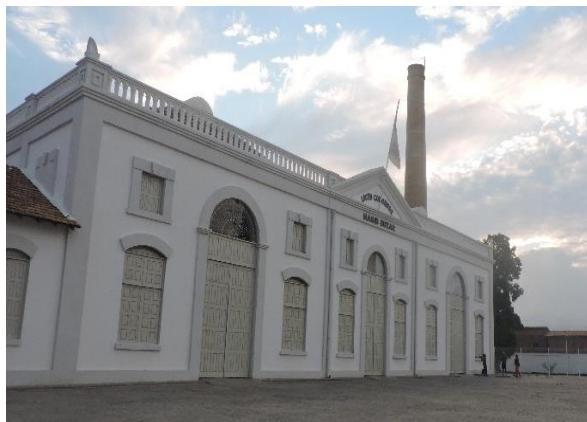
Figura 4 - Atual prédio da antiga Fábrica de tecidos – Escola Liceu codoense
