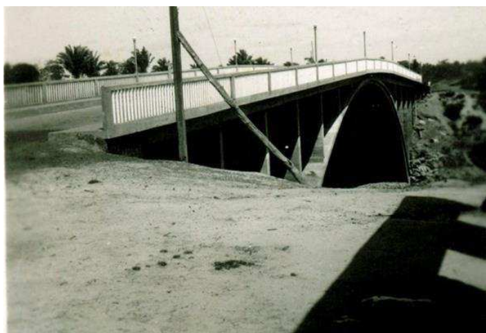
Figura 2- Ponte em Itapecuru-Mirim, MA
