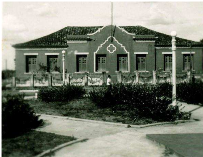
Figura 1- Prédio do Grupo Escolar em Itapecuru- Mirim, MA
