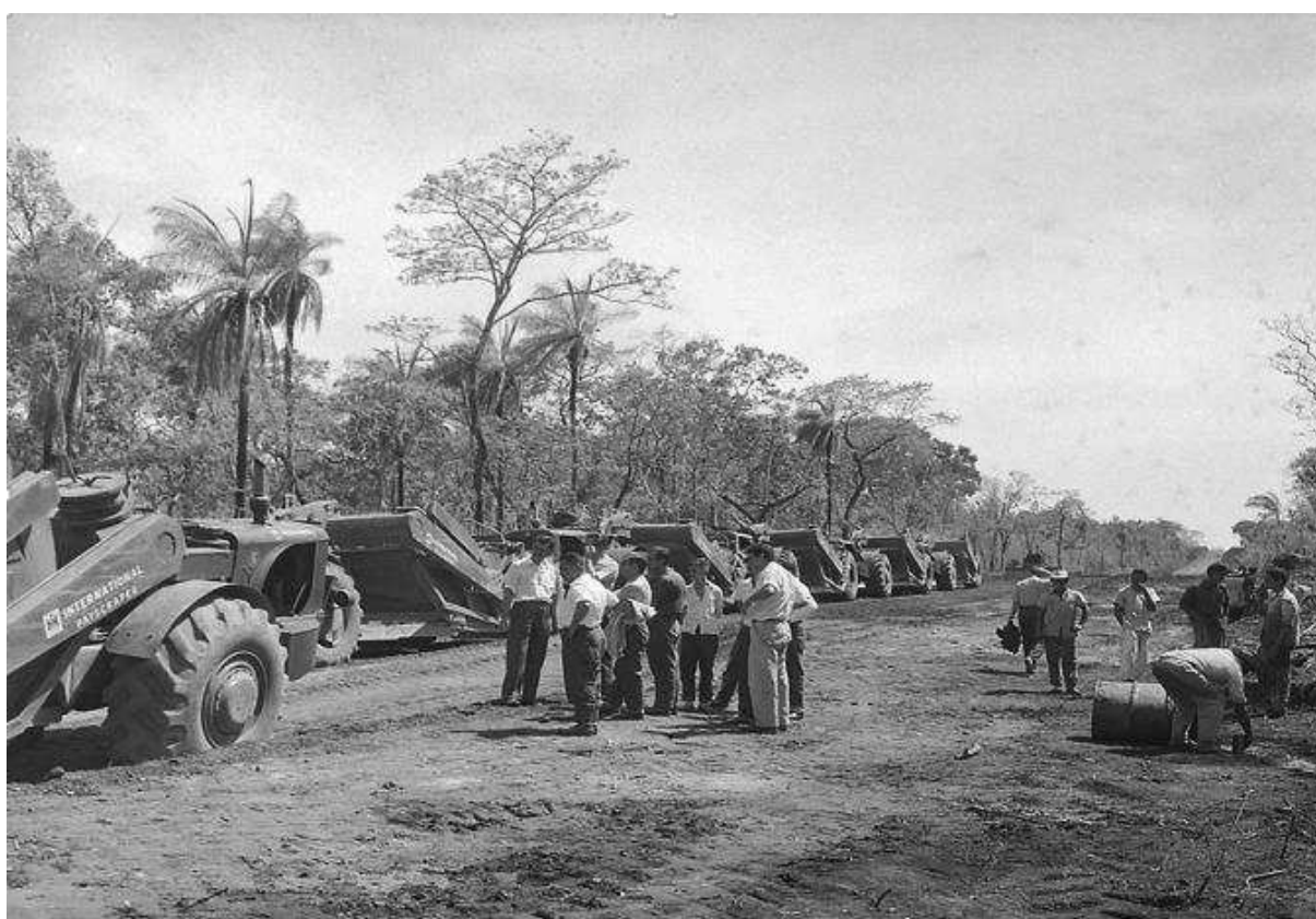
Figura 2. Desmatamento para a construção da BR-222
