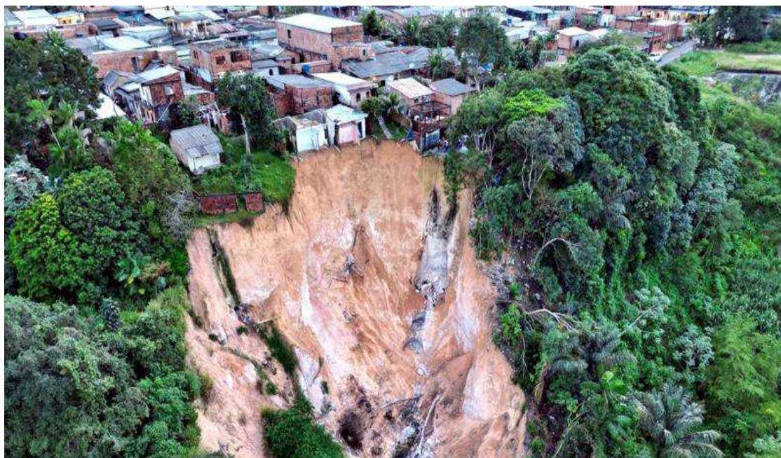
Figura 43. Pressão de uso urbano próximos às voçorocas em Santa Luzia - MA
