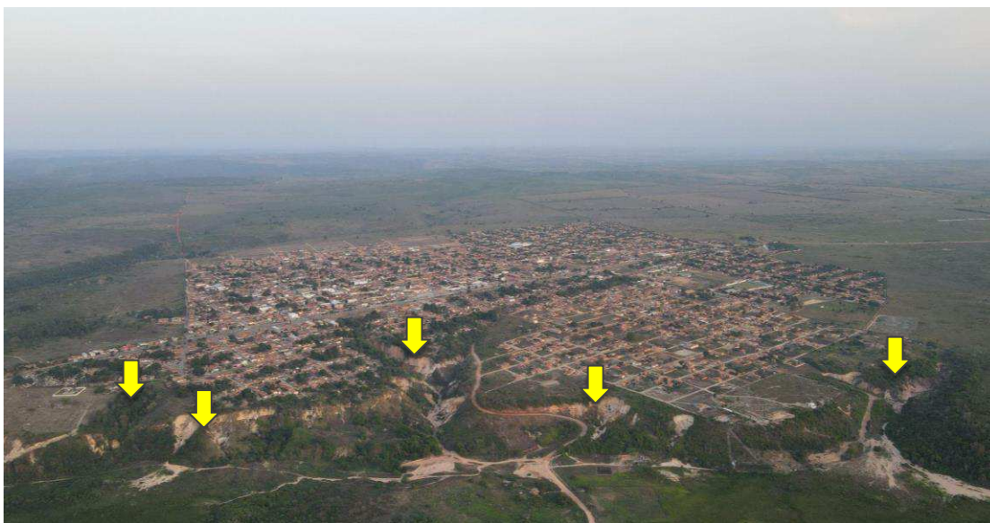
Figura 19. Voçorocas no grupo Latossolo em Bom Jesus das Selvas
