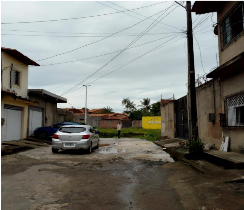
Foto 13: Casas em melhor estrutura, Parque Sabiás, margem direita, setor 6.
