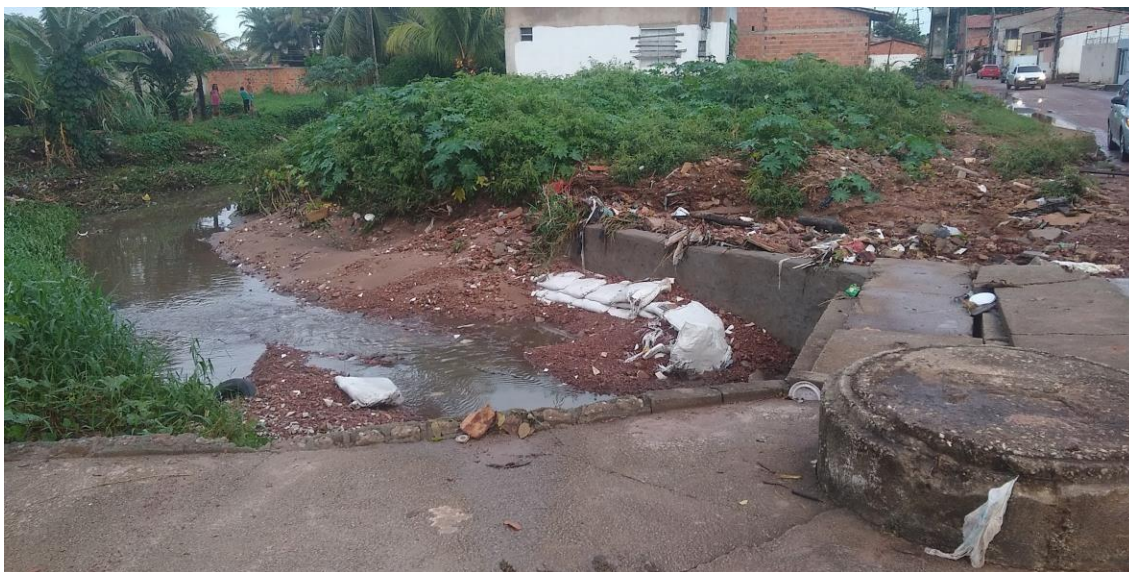
Foto 16: Local onde criança caiu no leito do rio - setor 6.
