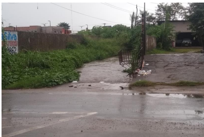
Foto 3: Fim da Canalização setor 3
