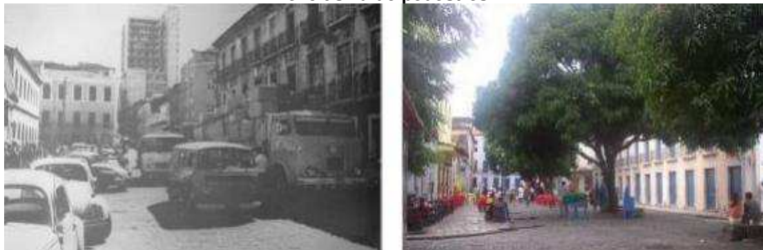
Figura 27 - Praça do Comércio em 1986 revelando ao caos urbano e a invasão de veículos pesados e após as intervenções do PPRCHSL com a área arborizada e transformada em via exclusiva de pedestres
