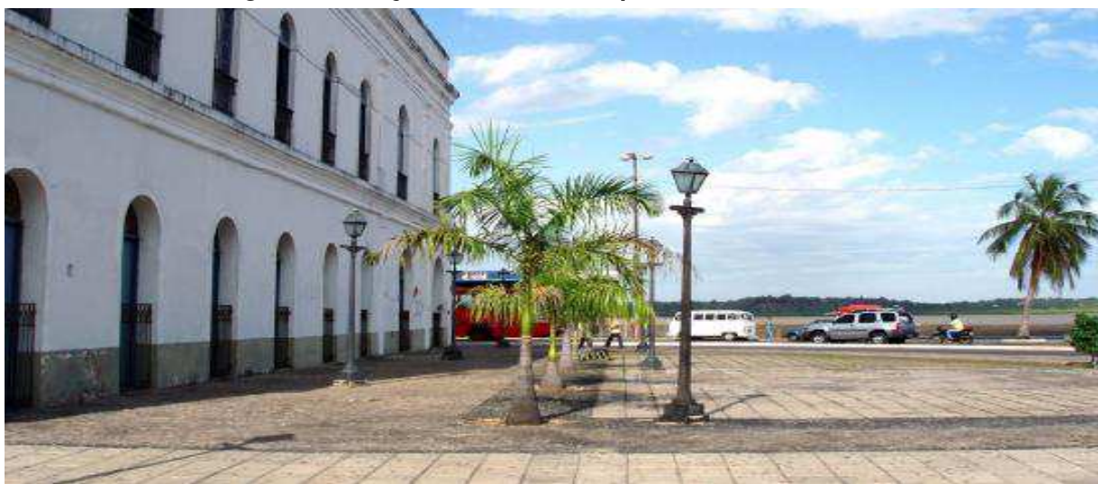
Figura 14 - Praça dos Catraieiros após as obras
