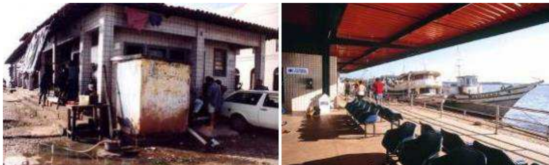
Figura 40 - Situação de abandono da estação de passageiro do porto da Praia Grande e após a reconstrução
