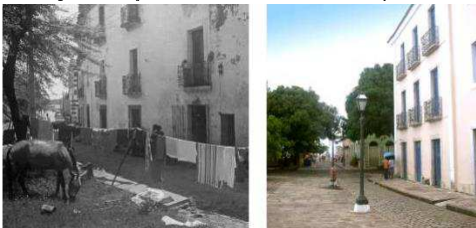
Figura 10: Praça do Poeta Nauro Machado antes e depois das obras
