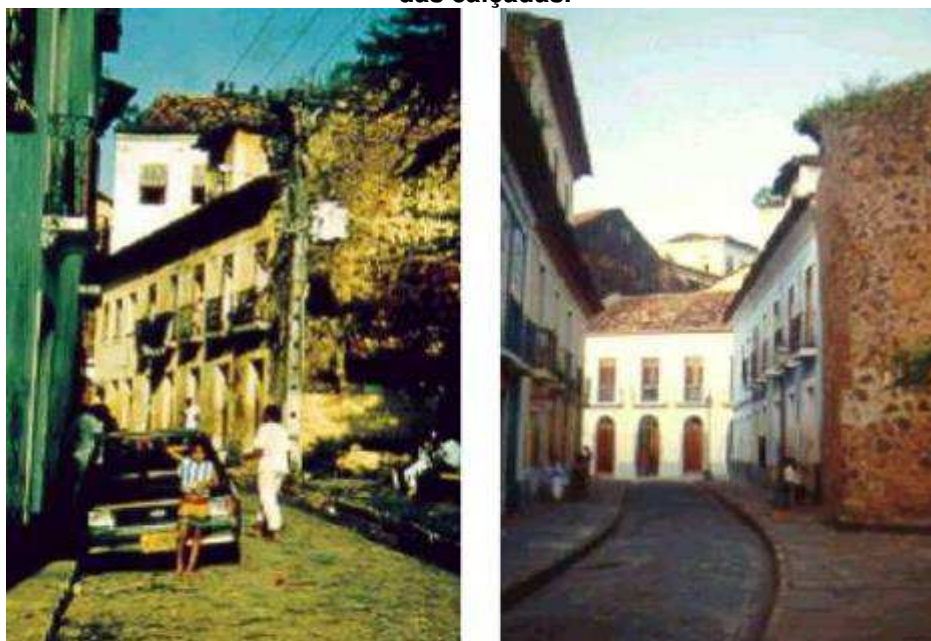
Figura 33 - Retirada de poste de concreto com transformador conjugada com o alargamento das calçadas.
