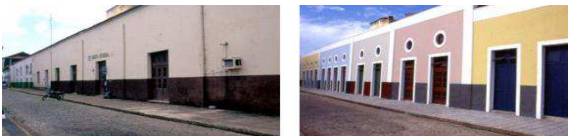
Figura 36 - Fachadas dos antigos depósitos do porto que estavam fechados e após sua adaptação para abrigar moradias
