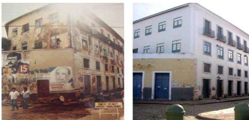
Figura 29 - Rua Portugal antes e depois das obras.
