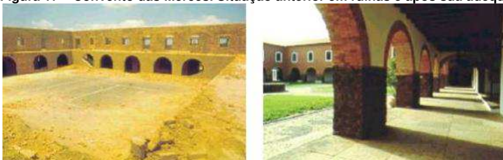
Figura 17 – Convento das Mercês. Situação anterior em ruínas e após sua adequação
