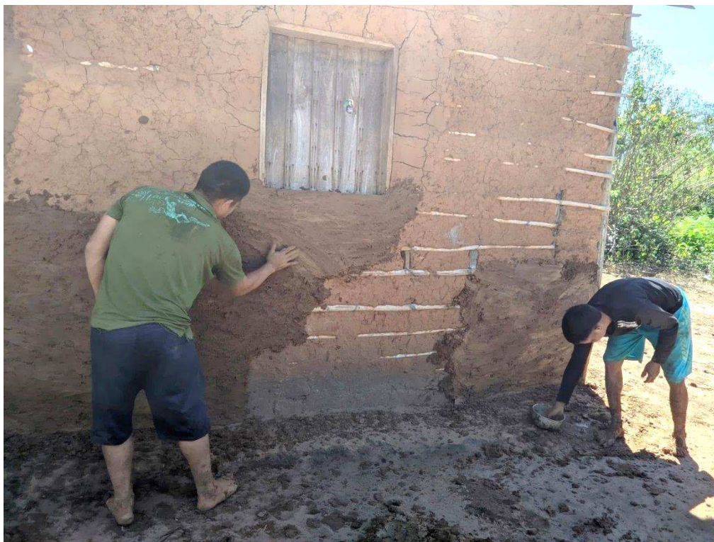
Figura 14 – Preenchimento das paredes com barro
