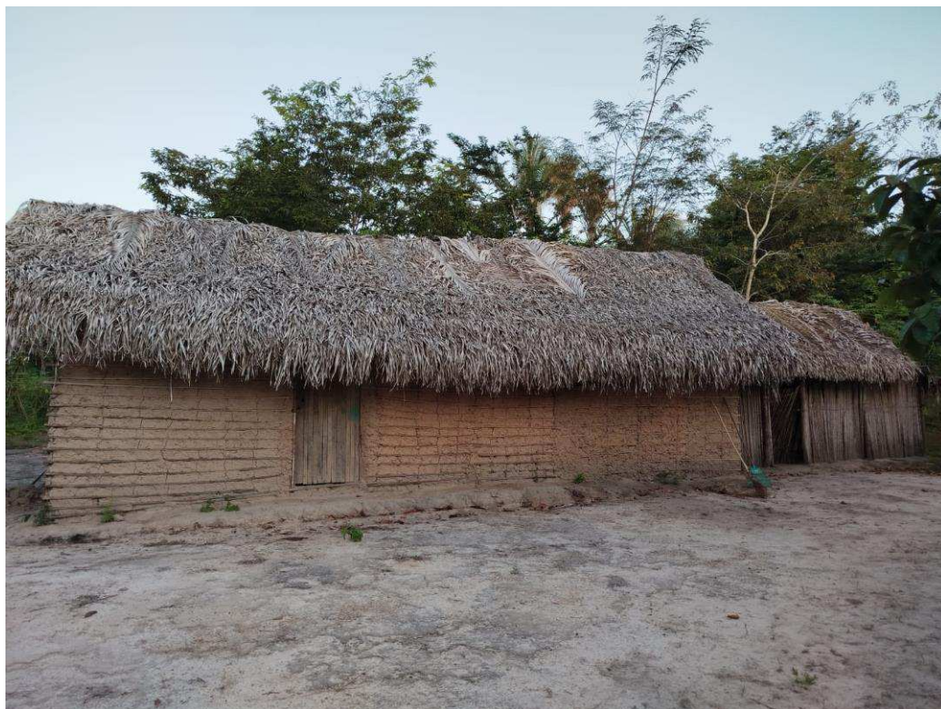
Figura – 02 Casa de Taipa
