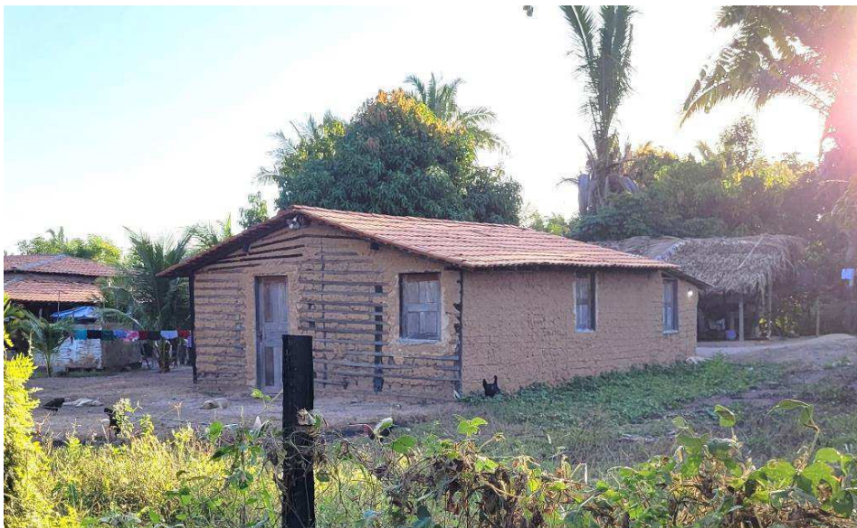
Figura 10 – Casa de taipa com cobertura de telha cerâmica
