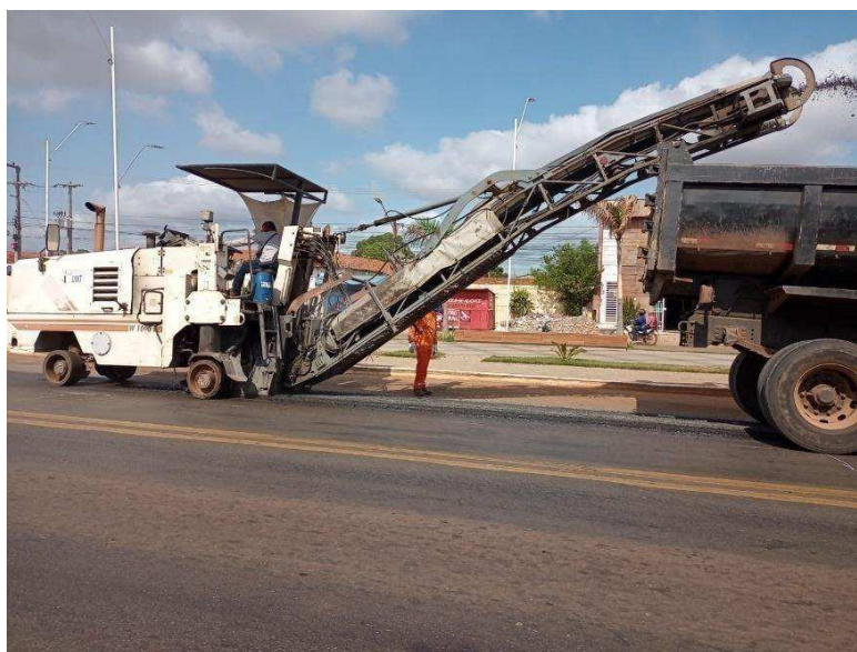
Figura 17 - Fresadora de Asfalto
