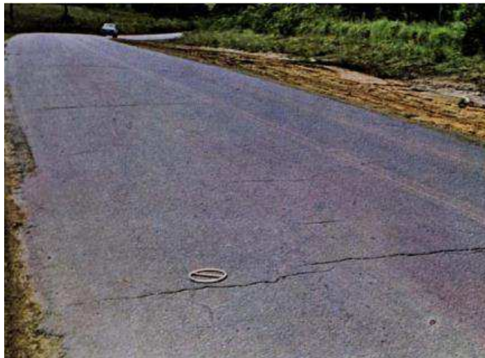
Figura 15 - Trinca Transversal isolada
