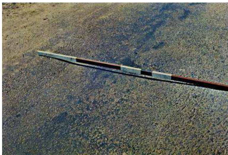
Figura 6 - Afundamento local
