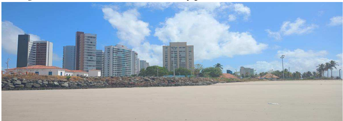
Figura 5 – Prédios milionários entorno do Espigão Costeiro, São Luís – MA
