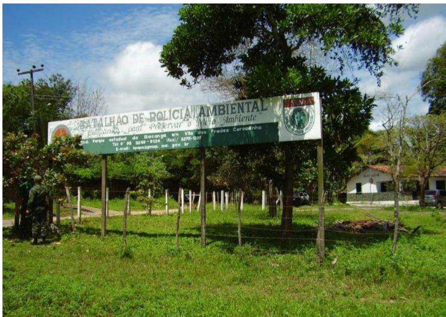
Figura 6 - Antigas instalações do BPA
