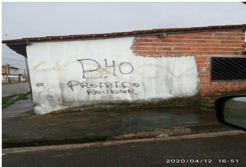
Figura 1- Foto do muro de uma casa na rua do cajueiro, loteamento Pontal da Ilha
