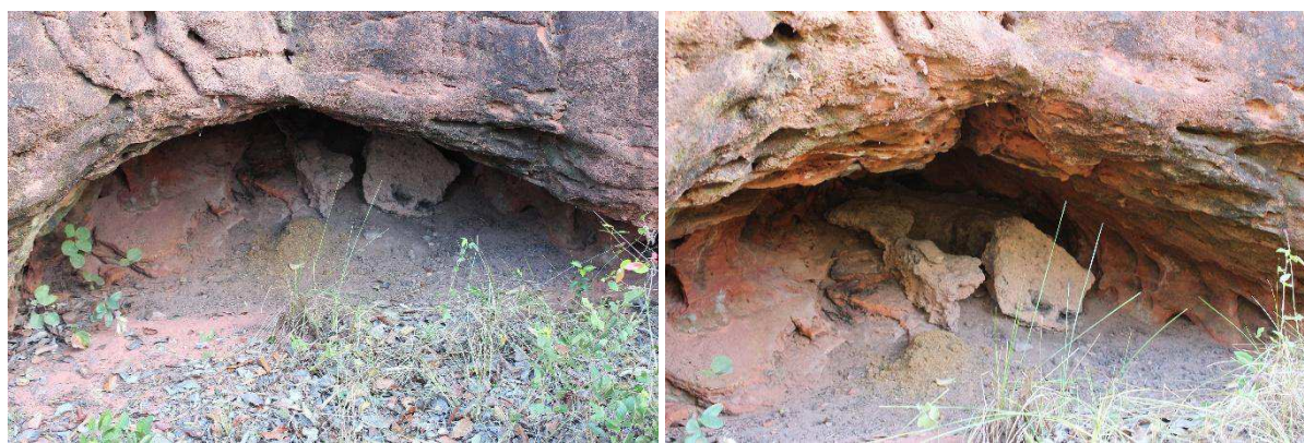
Figura 43 - Caverna Toquinha A: Blocos desabados B
