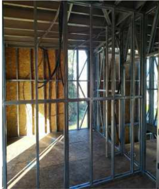
Figura 9 – Estrutura executada em Light Steel Frame
