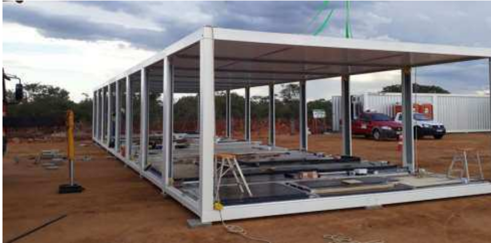
Figura 2 – Aplicação de estrutura de aço em uma construção modular
