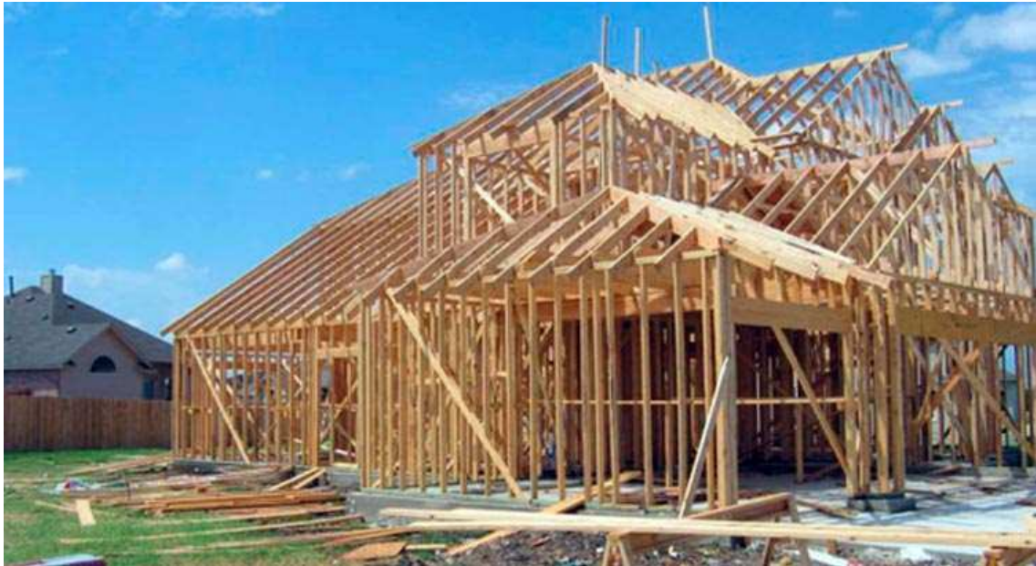
Figura 8 – Estrutura residencial aplicada com Wood frame.
