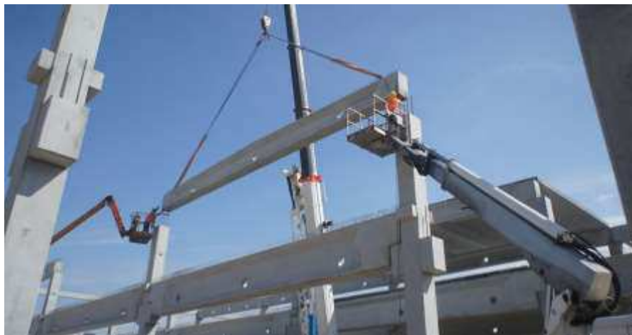
Figura 5 – Estrutura contendo pilares, vigas e laje pré-fabricados.
