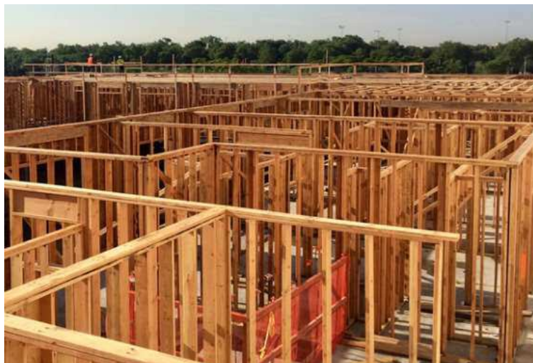
Figura 1 – Aplicação de madeira em construção modular
