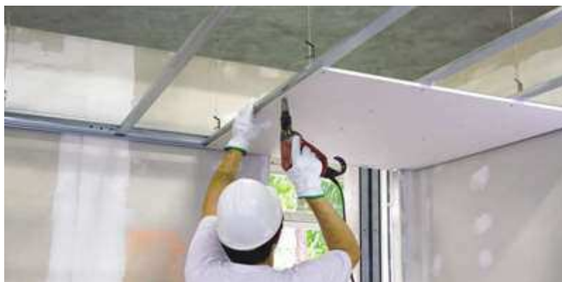
Figura 6 – Instalação de painel de drywall
