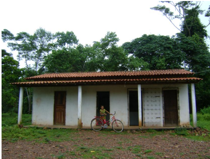
Foto 4 - Cantina da comunidade Três Poços, Lago dos Rodrigues. Fonte: GUSMÃO (2009)
