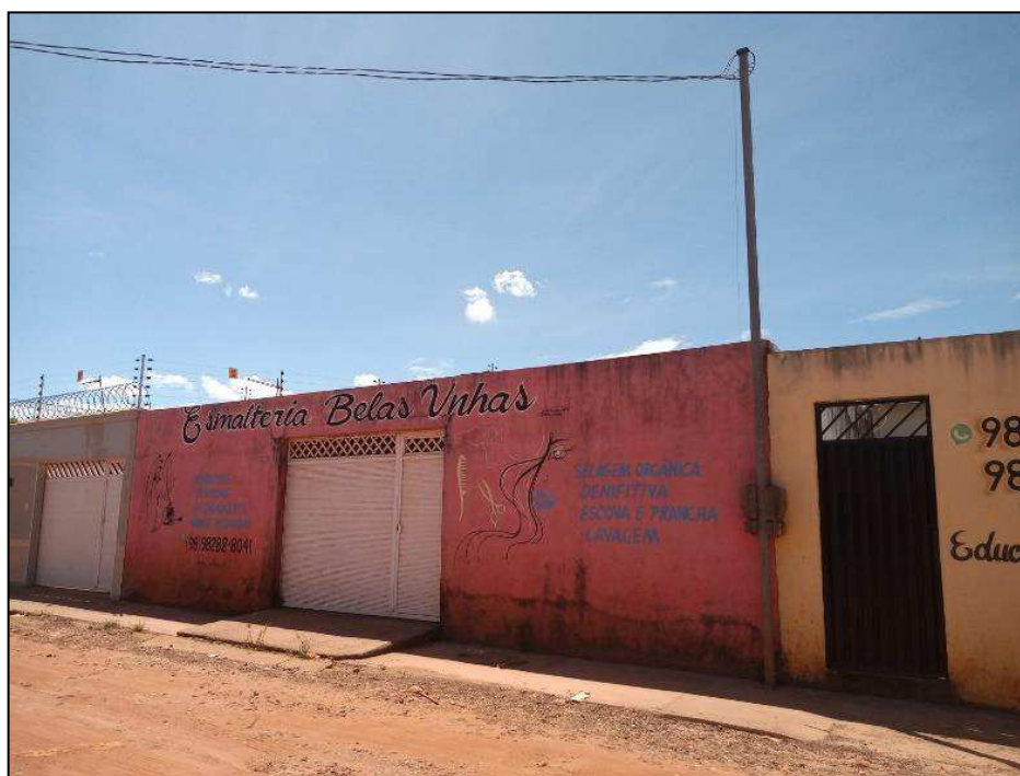
Figura 21 - Estabelecimento improvisado, ainda com estrutura residencial
