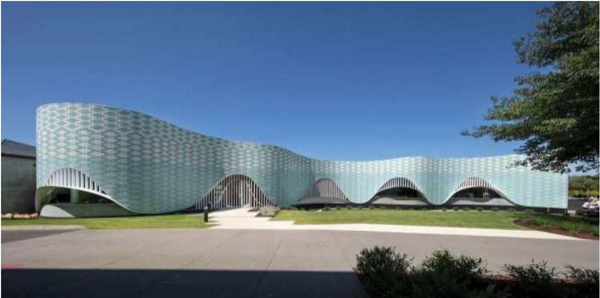
Figura 19. Fachada do Centro de Música da Escola Primária Penleigh e Essendon
