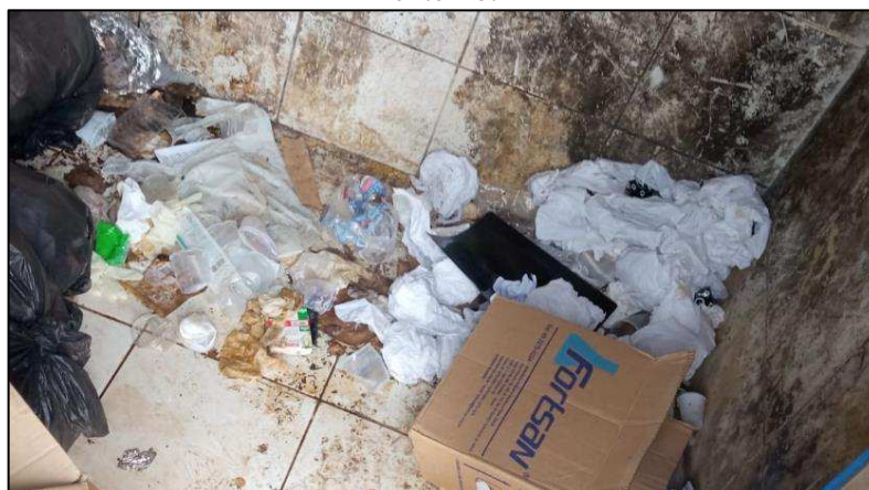
Figura 11: Resíduos comuns dispersos dentro do local de armazenamento externo.
