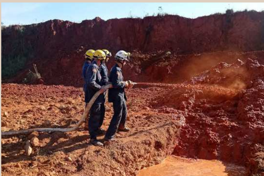
Técnica de Desmanche Hidráulico Fonte: CBMSC
