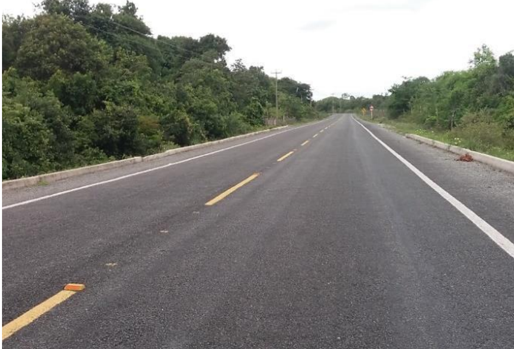
Figura 19- Rodovia MA-320 pavimentada.
