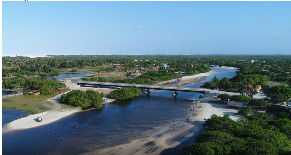
Figura 20- Ponte da Cidade de Santo Amaro
