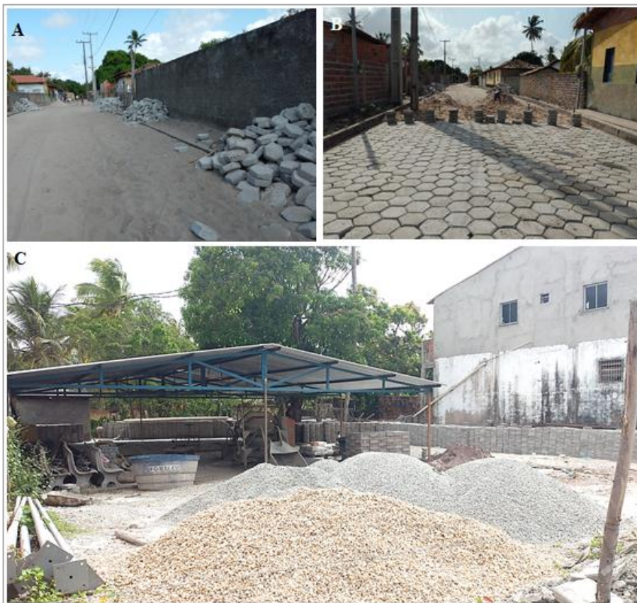
Figura 37- A e B ruas sendo calçadas com bloquetes. C. Fábrica de bloquetes e bancos de concreto.
