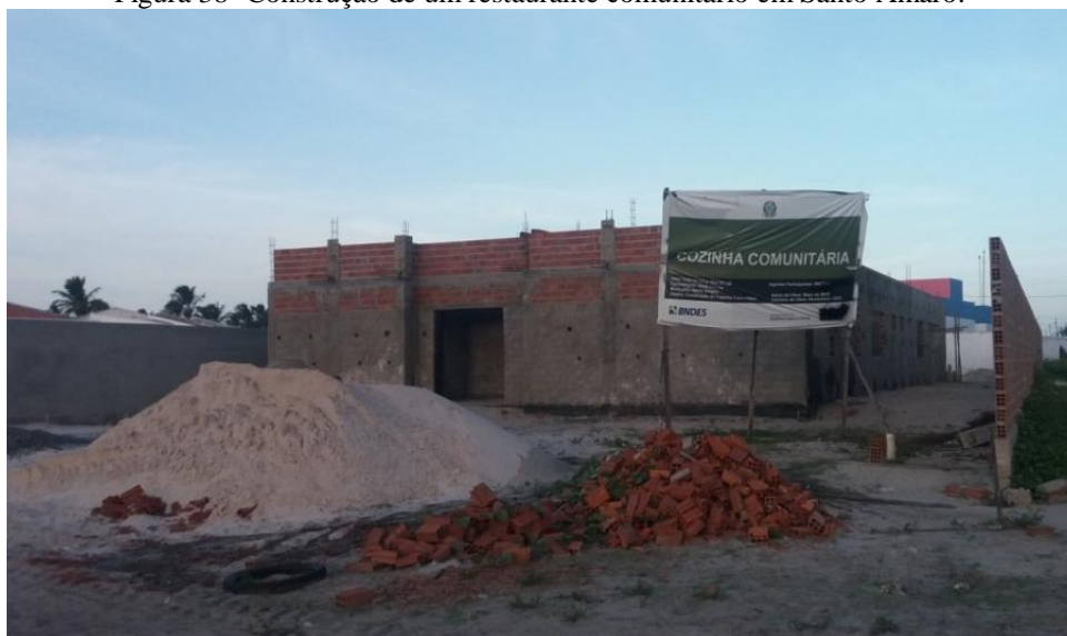
Figura 38- Construção de um restaurante comunitário em Santo Amaro.
