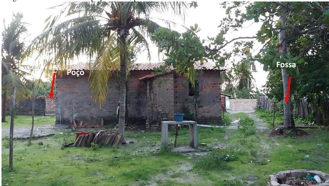
Figura 44- Distância entre poço e fossa, problema de saneamento básico na cidade de Santo Amaro.
