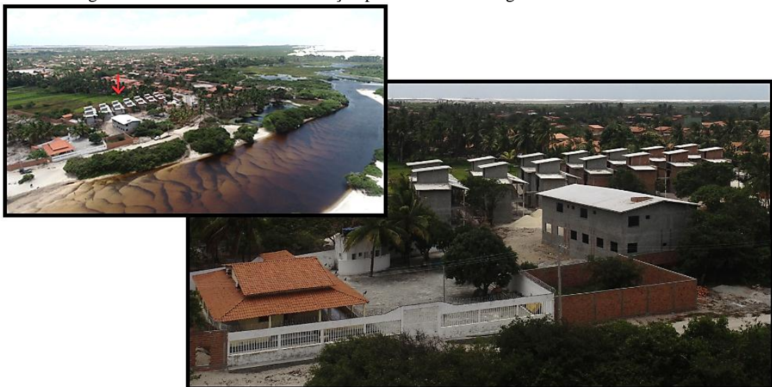
Figura 35- Condomínio em construção próximo ao rio Alegre.
