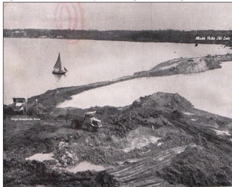
Figura 6 - Obras de construção da barragem do Bacanga
