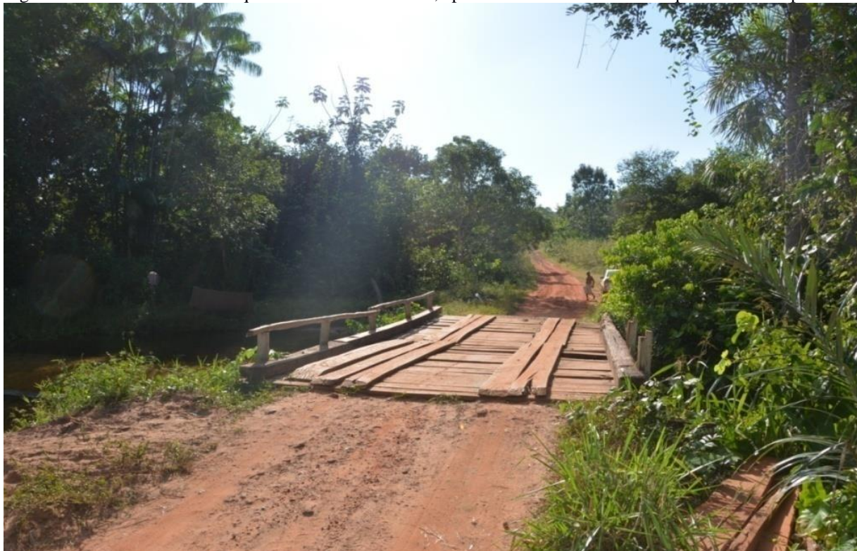
Figura 44- Estrada vicinal que dá acesso a Solta, ponte sobre o rio Solta que limita o povoado
