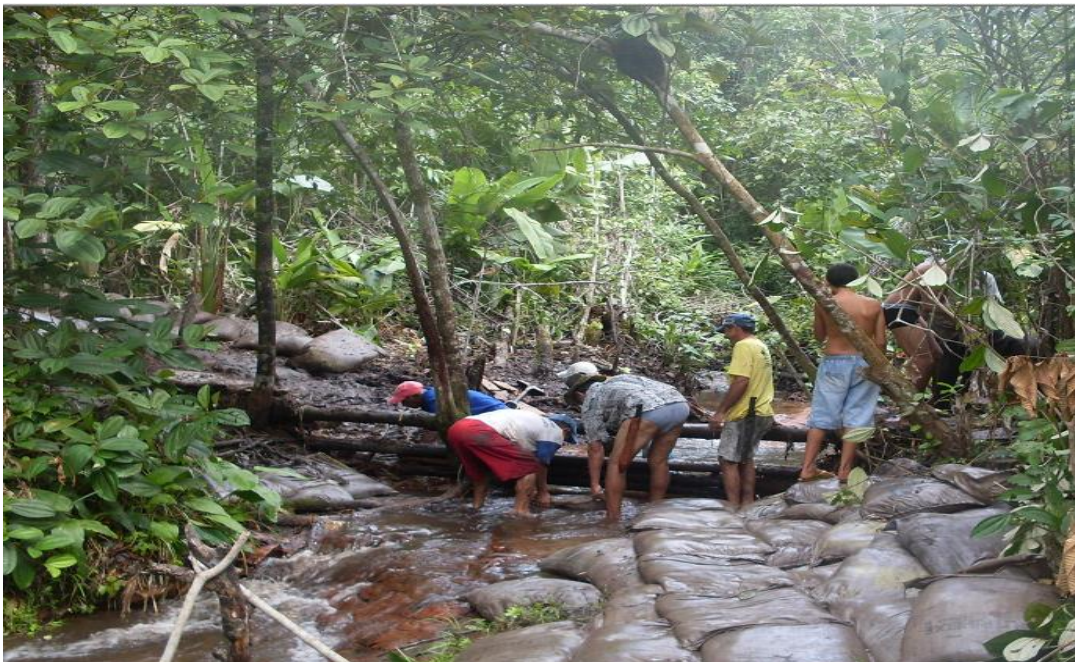
Figura 15- Trabalho em mutirão para construção de um ponto de captação da água
