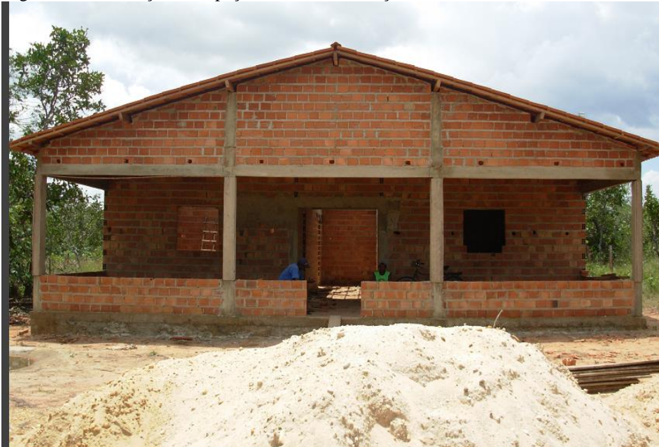
Figura 12- Construção do espaço físico da Associação Bezerra de Morais – ABM, em 1996
