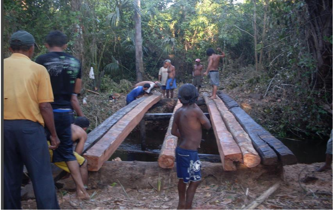
Figura 14- Trabalho em mutirão para construção de uma ponte em ribeirão no povoado
