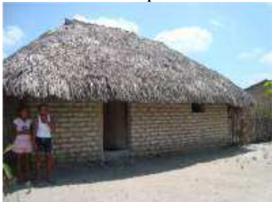
Figura 63 – Casa de adobe não revestido com cobertura de palha de buriti
