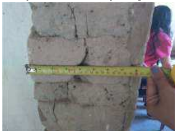
Figura 31 - Detalhe da largura da parede
