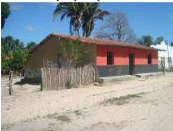
Figura 28 – Fachada de adobe revestido e com aplicação de pintura
