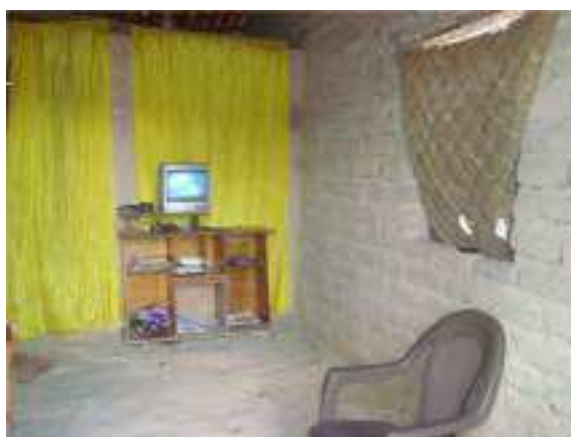
Figura 41 – Cortinas como vedação nas janelas
