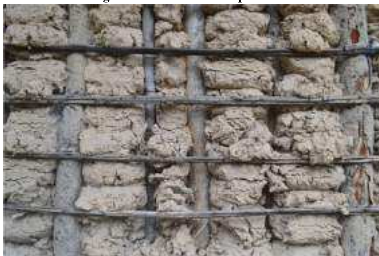
Figura 32 - Detalhe da taipa de mão
