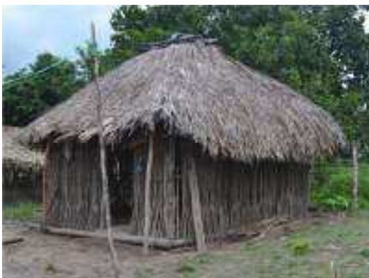
Figura 68 – Construção de apoio para depósito
