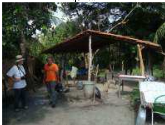
Figura 67 – Construção de apoio no quintal
