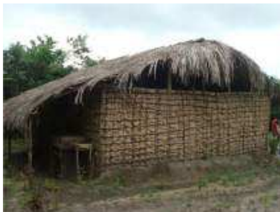
Figura 27 – Casa de taipa com fundação reforçada em terra batida na parte externa
