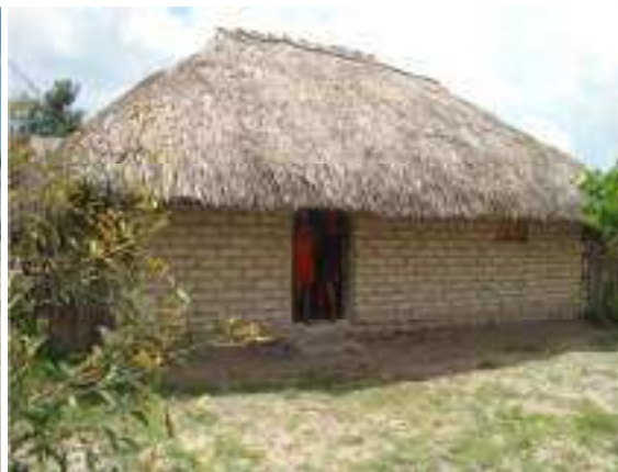
Figura 29 - Fachada de adobe sem revestimento
