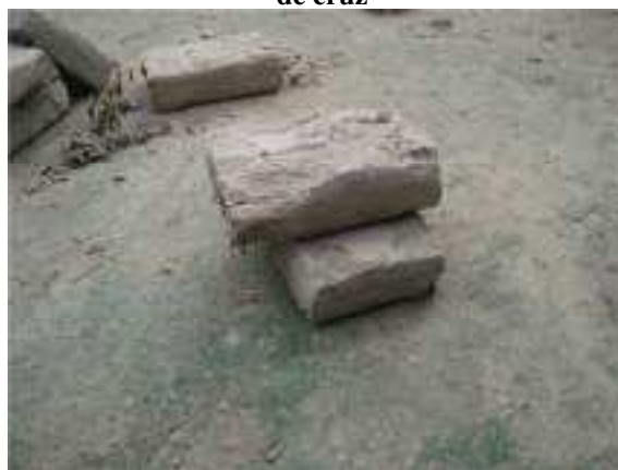
Figura 25 – Disposição dos adobes em forma de cruz
