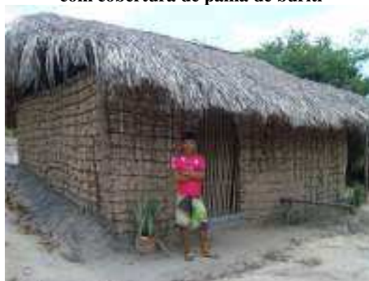
Figura 65 – Casa de taipa não revestida com cobertura de palha de buriti
