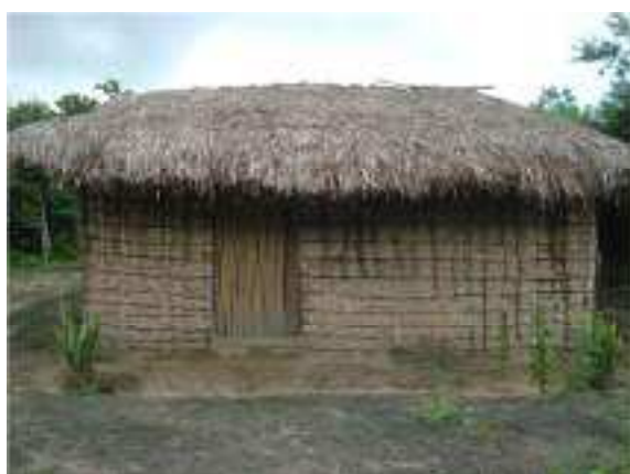
Figura 26 – Casa de taipa com fundação em terra batida e esteios de madeira
