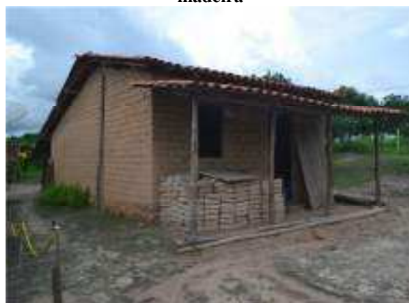
Figura 34 – Telha cerâmica com troncos de madeira
