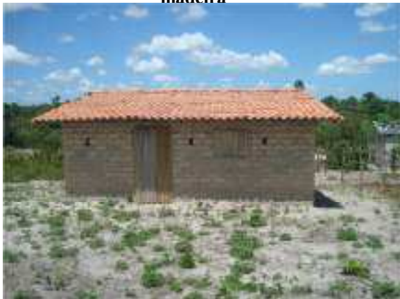
Figura 39 – Esquadrias de ripas de madeira
