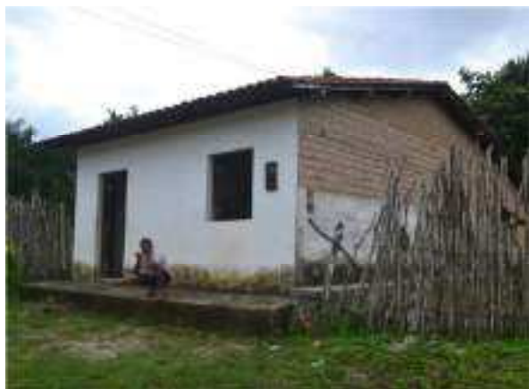
Figura 33 – Telha cerâmica com madeiramento
