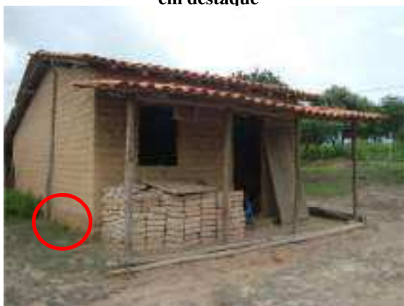
Figura 24 – Fundação de adobe com “berço” em destaque
