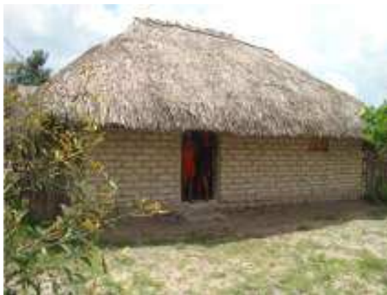
Figura 29 - Fachada de adobe sem revestimento
