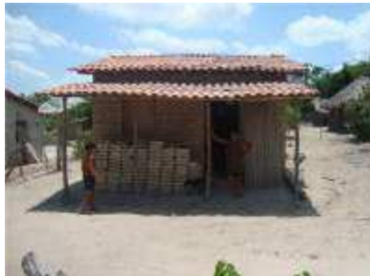
Figura 64 – Casa de adobe não revestido com cobertura de telha cerâmica
