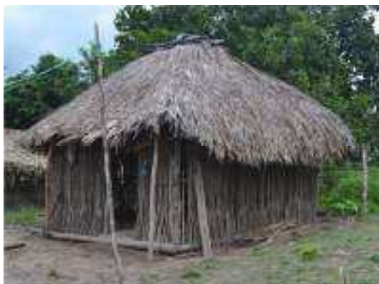
Figura 68 – Construção de apoio para depósito
