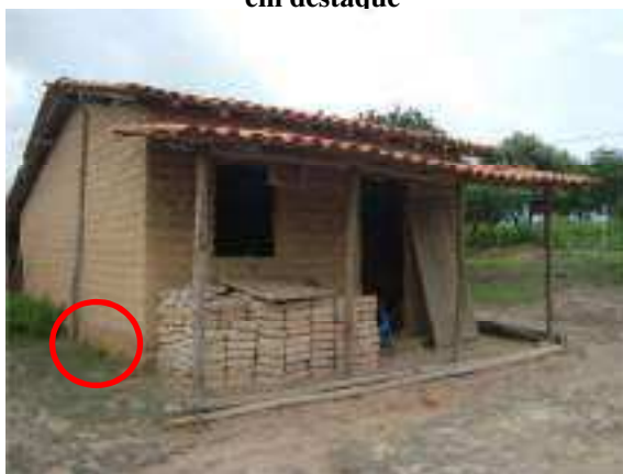
Figura 24 – Fundação de adobe com “berço” em destaque
