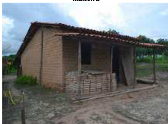
Figura 34 – Telha cerâmica com troncos de madeira
