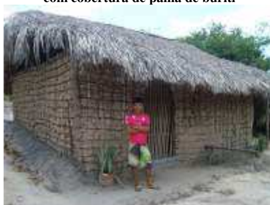
Figura 65 – Casa de taipa não revestida com cobertura de palha de buriti
