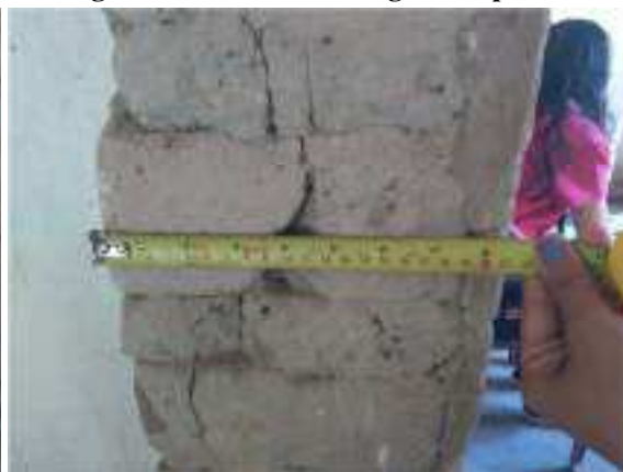
Figura 31 - Detalhe da largura da parede
