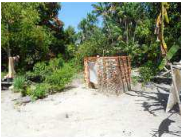
Figura 53 – Banheirinho de alvenaria
