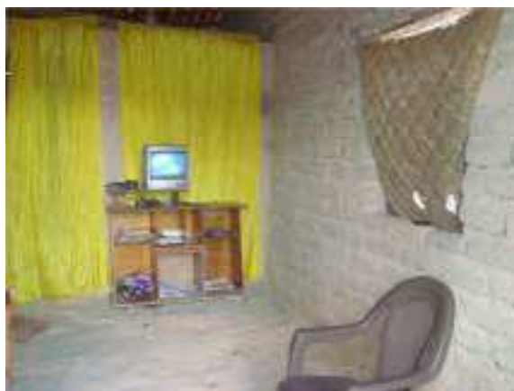
Figura 41 – Cortinas como vedação nas janelas
