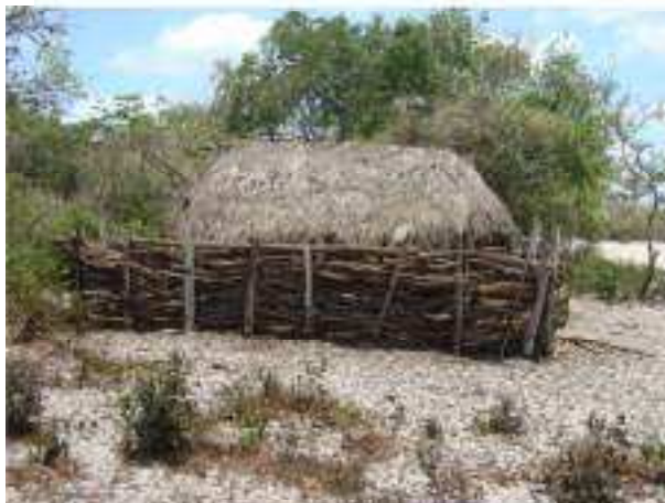
Figura 51 – Chiqueiro construído com troncos de madeira e palha
