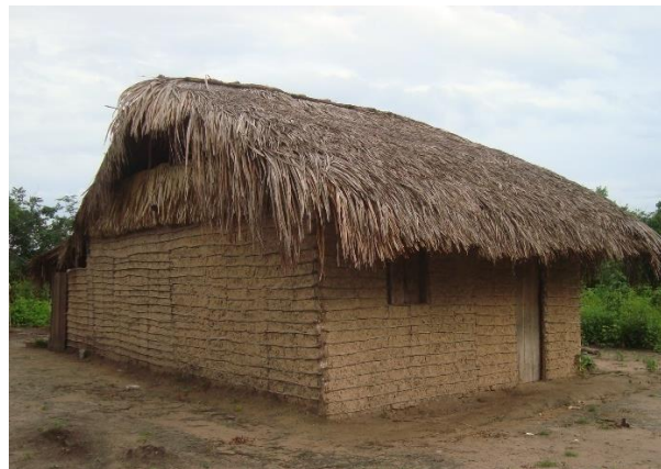
Figura 23 – Cobertura de palha, utilizando troncos de madeira junto a folhas de Buriti
