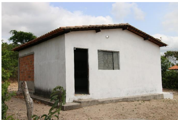
Figura 100– Fachada da casa de M.N
