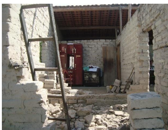
Figura 56 – Casa de J.R.N, em fase de demolição
