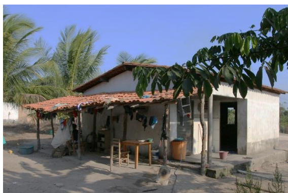
Figura 75 – Meia-água da casa de A.A
