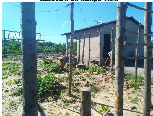
Figura 62– Casa de M.J.S ao lado de estrutura de madeira da antiga casa
