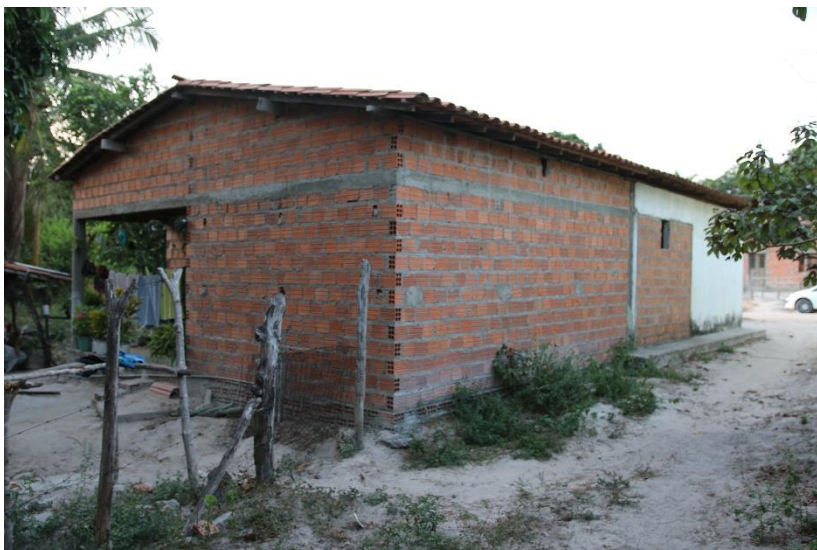
Figura 79– Reforma realizada na casa de J.R.N e A.C.B
