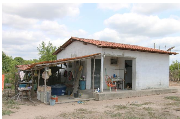
Figura 76 – Meia-água na casa de J.A.N e T.S
