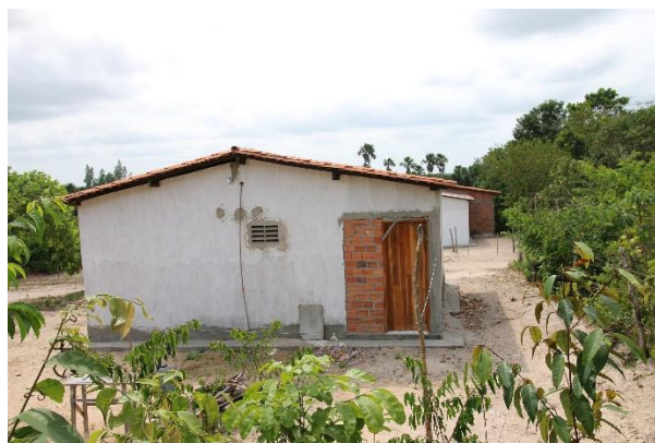
Figura 74 – Reforma realizada por M.J.N, vista em tijolo aparente e de porta de madeira
