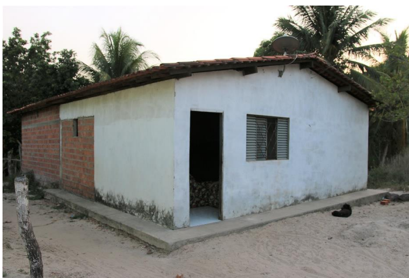
Figura 80– Fachada da casa de J.R.N e A.C.B após reforma
