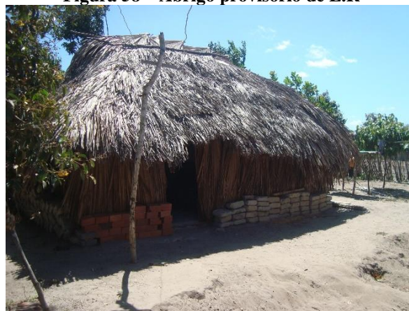
Figura 58 – Abrigo provisório de L.R
