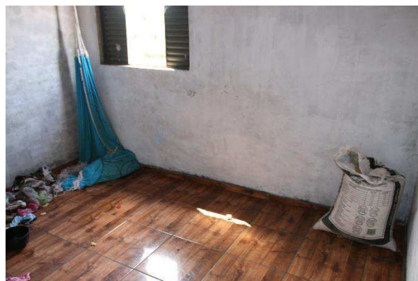
Figura 119– Segundo quarto com menor uso na casa de M.J.S e T.S
