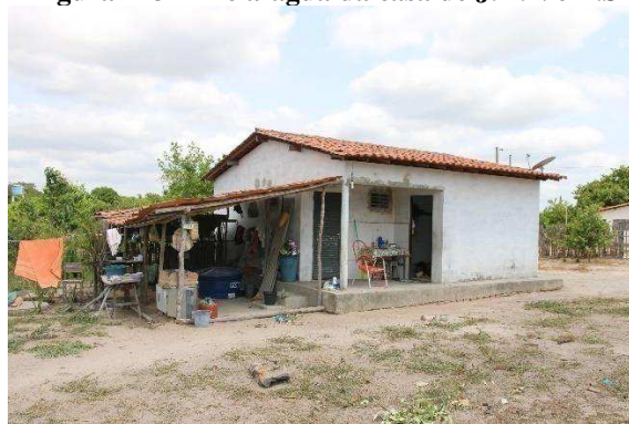
Figura 123 – Meia-água da casa de J.A.N e T.S
