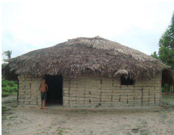
Figura 18 – Casa de taipa, de O.F
