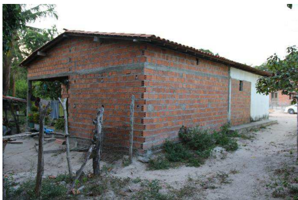
Figura 73 – Reforma realizada por J.R (ampliação em tijolo aparente)
