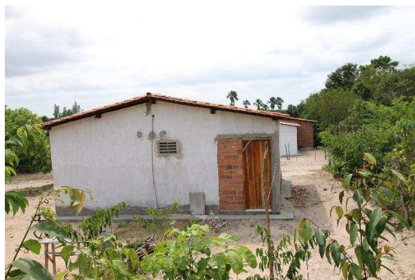
Figura 74 – Reforma realizada por M.J.N, vista em tijolo aparente e de porta de madeira
