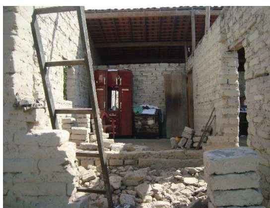
Figura 56 – Casa de J.R.N, em fase de demolição
