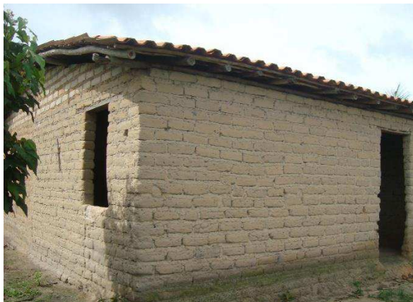
Figura 22 – Cobertura híbrida, utilizando telhas cerâmicas e troncos de madeira
