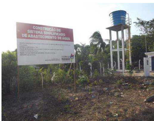
Figura 7– Construção do sistema de abastecimento simplificado de água
