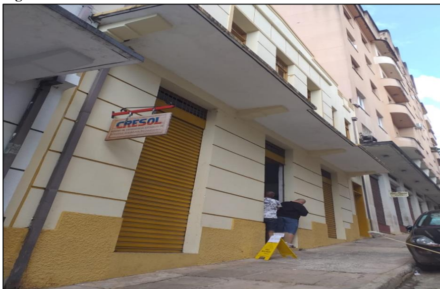
Figura 9 – Fachada dos Pontos de Venda - CRESOL
