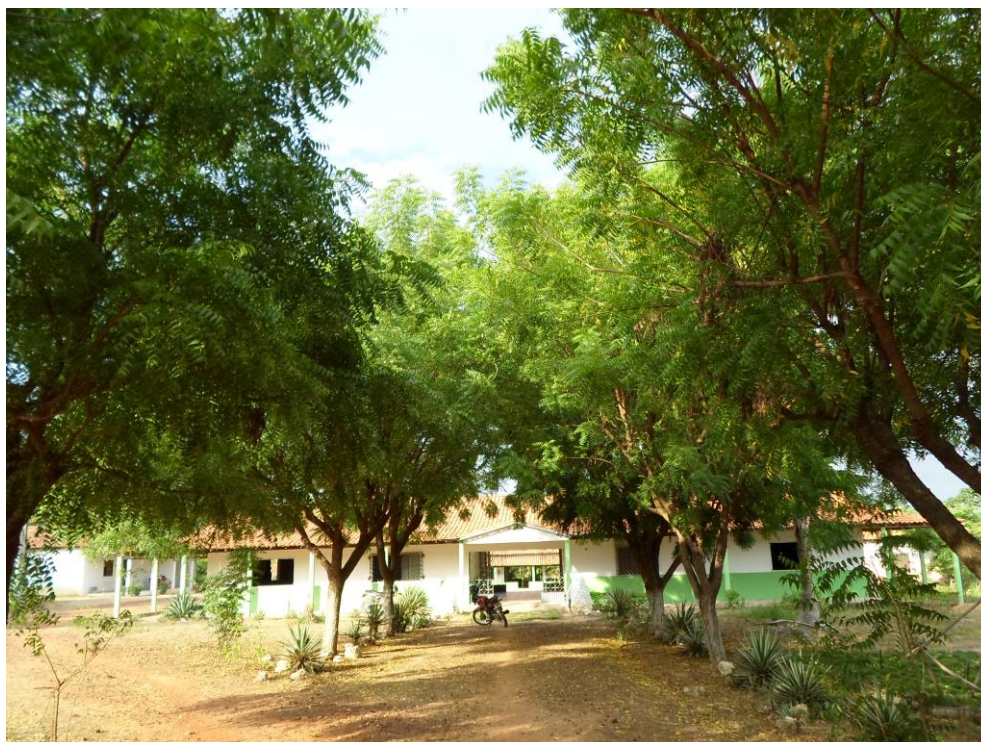
Figura 12 – Vista frontal do prédio do CEFFA
