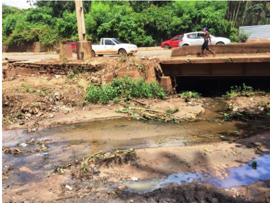
Figura 18: Rio Paciência em trecho de interseção com a MA-201 durante o período da Intervenção
