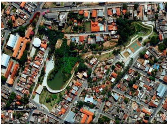
Figura 25: Parque 1º de Maio após a conclusão da obra
