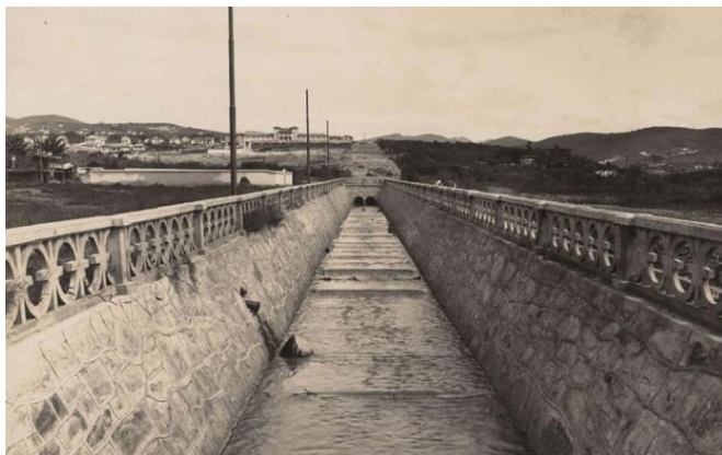
Figura 6: Canalização do Córrego do Leitão em Belo Horizonte entre os anos de 1920 e 1930.
