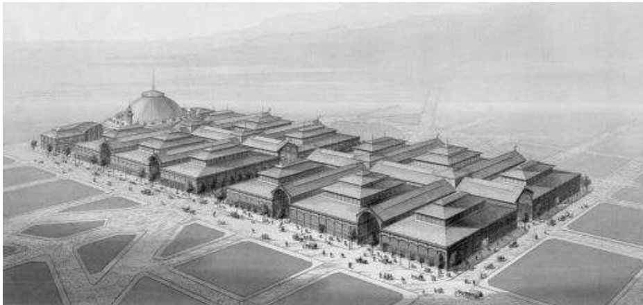
FIGURA 04: VISTA AÉREA DOS PAVILHÕES DO MERCADO PÚBLICO DE LES HALLES DE PARIS, EM 1863
