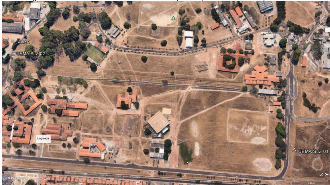
Figura 39: Posicionamento dos Marcos de Apoio implantados no Campus Paulo VI
