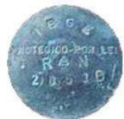
Figura 10: Diferentes formas de materialização de pontos: ponto pintado na calçada, marco de concreto, chapa de identificação de pontos
