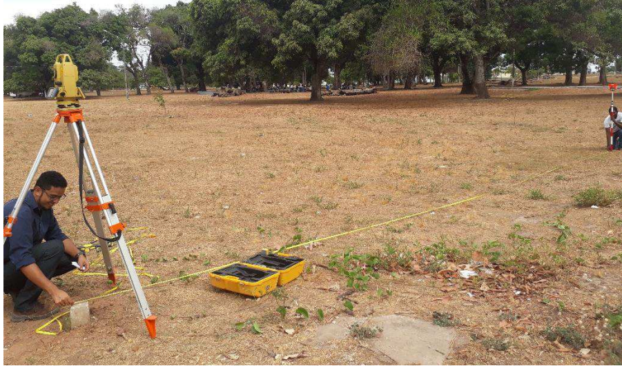
Figura 43: Locação com Estação Total pelo Método Polar
