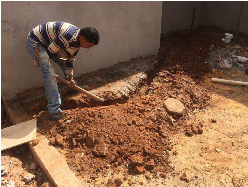
Figura 32 - Desvio de caminho da tubulação sanitária
