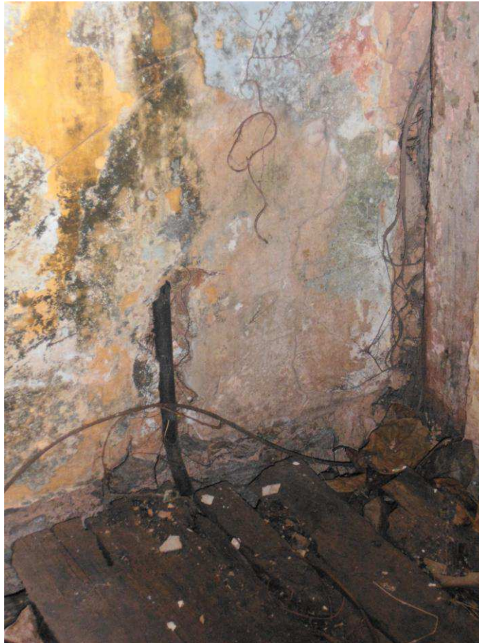
Fotografia 7 – Argamassa de alvenaria de pedra e madeira
