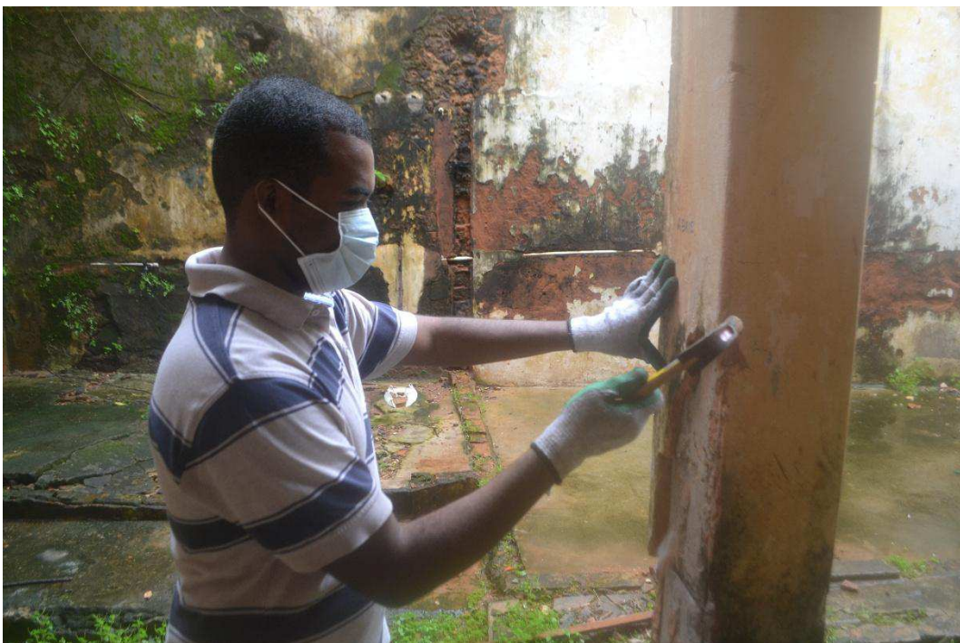
Fotografia 15 – Demolição e remoção de reboco de pilar P1
