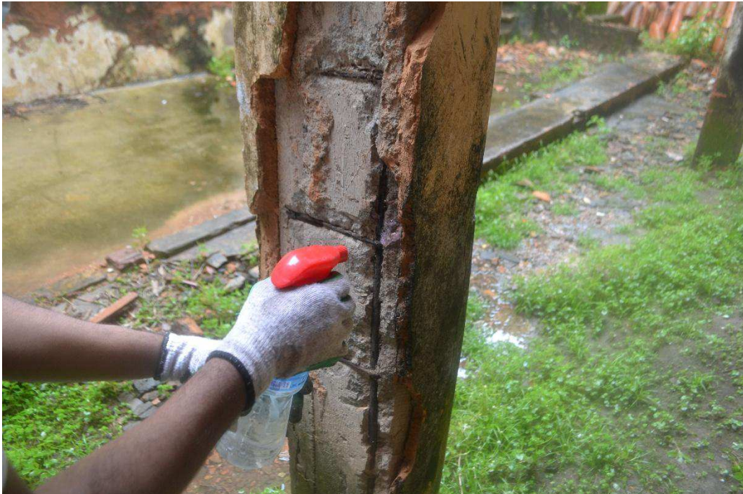
Fotografia 16 – Aplicação de fenolftaleína no pilar de concreto
