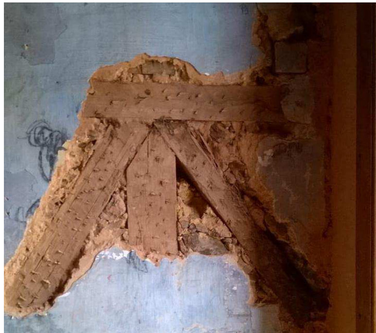
Fotografia 24 – Alvenaria de pedra argamassada com madeira
