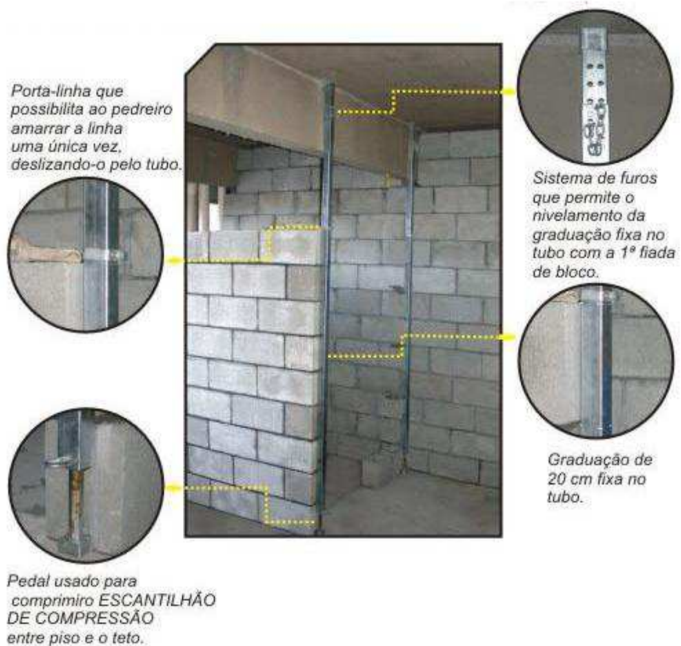
Figura 7 – Escantilhão para auxiliar a execução de alvenaria de vedação
