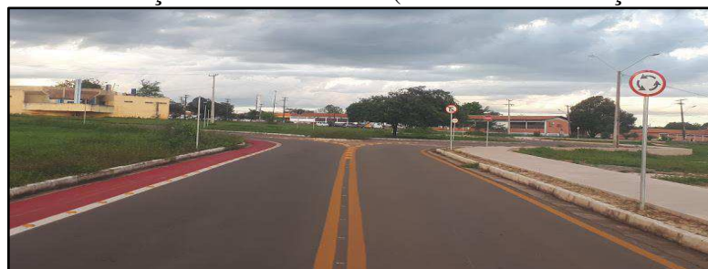
Figura 76 - Sinalização Vertical - R-33 (Sentido de circulação na rotatória)
