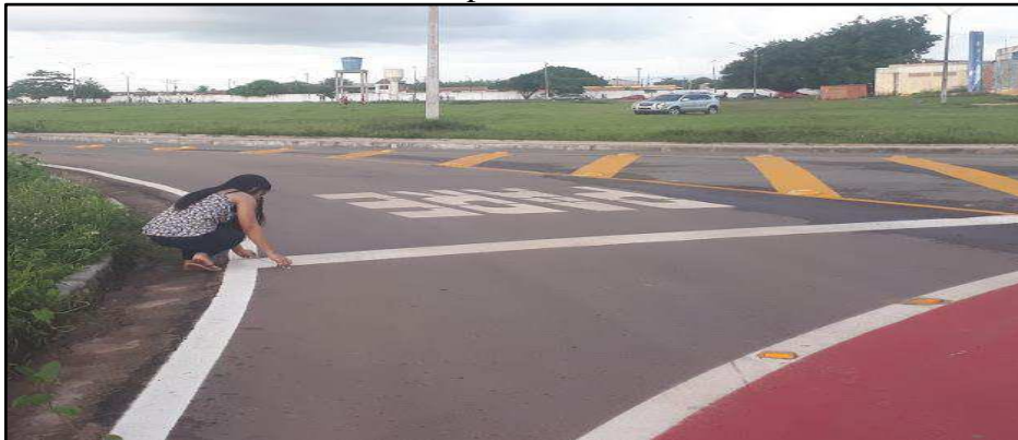
Figura 80 - Sinalização horizontal - Marcas Transversais (linha de retenção) e legenda inscrita no pavimento
