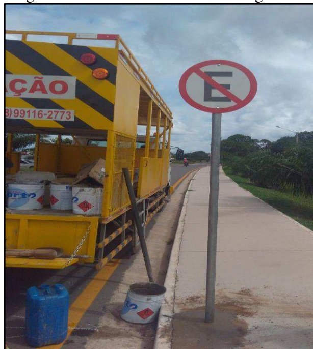
Figura 73 - Acabamento feito com argamassa
