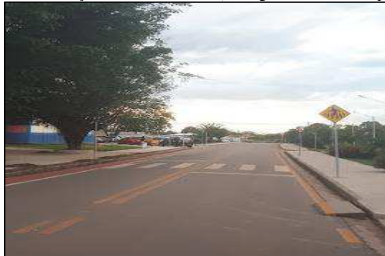
Figura 78 - Sinalização Vertical - A-32b (Passagem sinalizada de pedestres)
