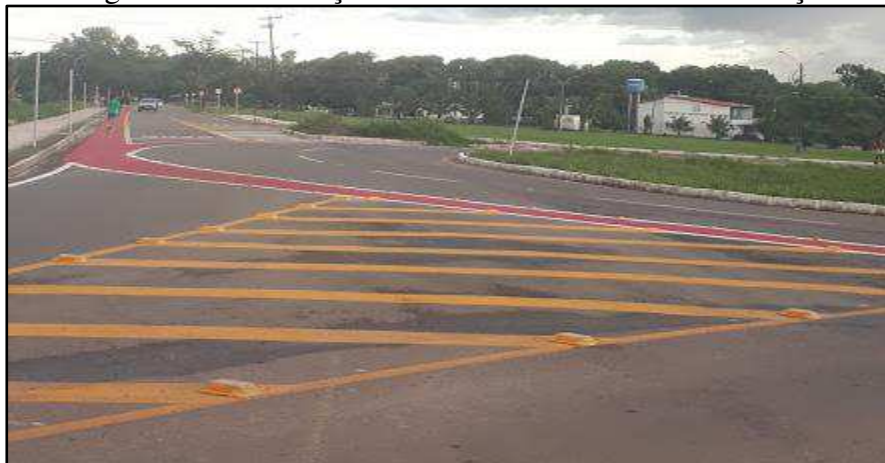
Figura 81 - Sinalização horizontal - Marcas de Canalização
