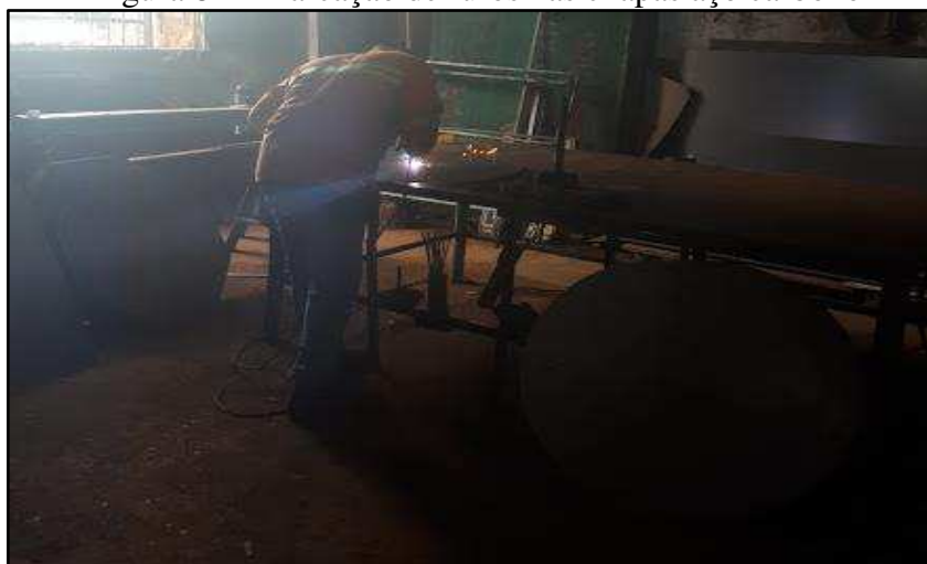
Figura 84 - Marcação de furos nas chapas aço carbono
