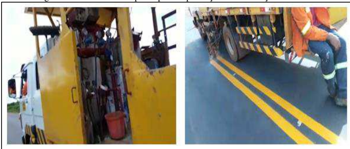
Figura 90 - Caminhão adaptado para implantação da sinalização horizontal
