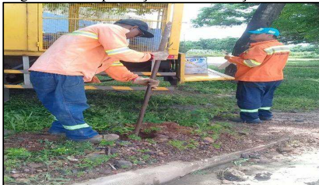
Figura 71 - Implantação da Sinalização Vertical
