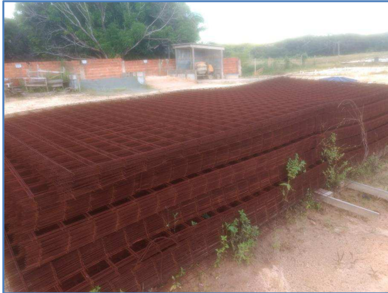
Figura 26 - Estoque de telas no canteiro de obras
