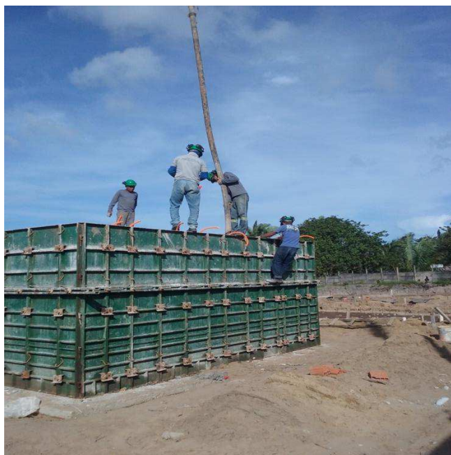
Figura 42 - Processo de lançamento do concreto
