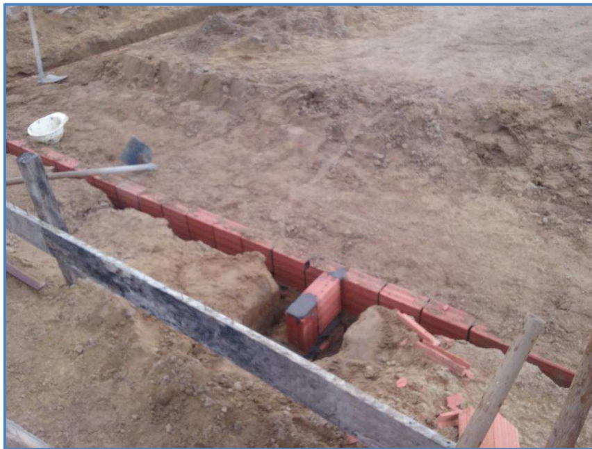
Figura 20 - Processo de execução da fundação
