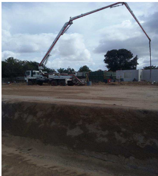
Figura 39 - Concretagem das paredes
