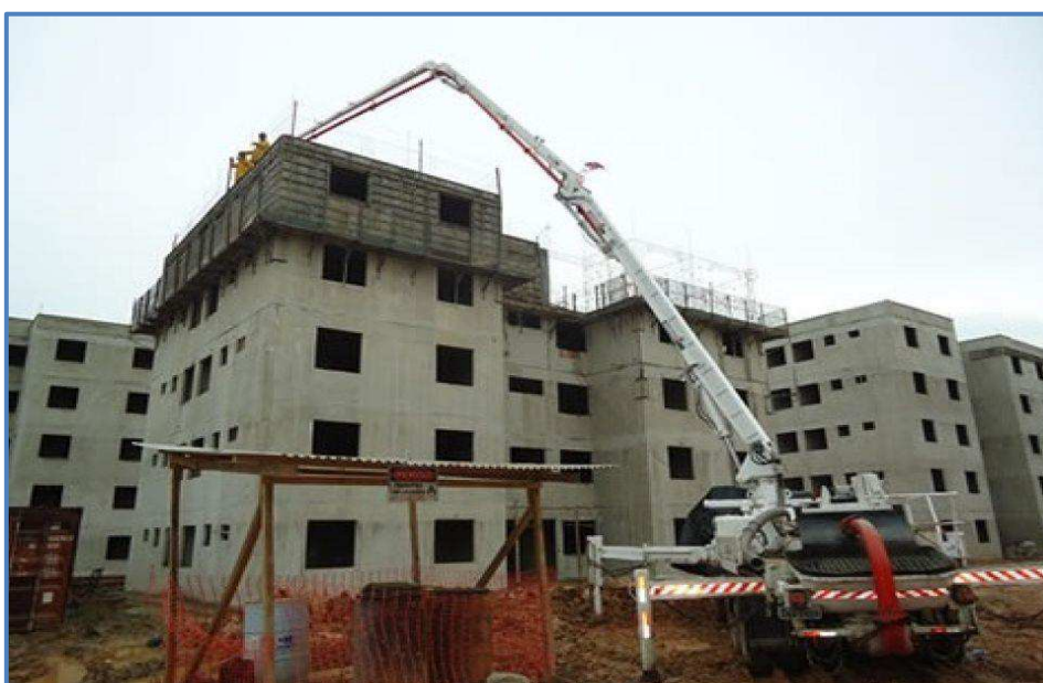
Figura 8 - Concretagem de uma parede
