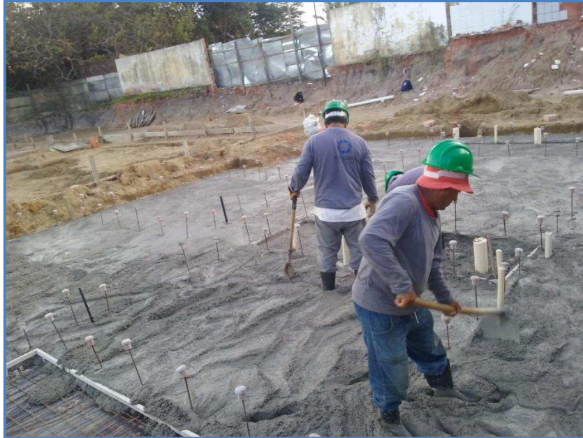
Figura 24 - Aplicação do concreto
