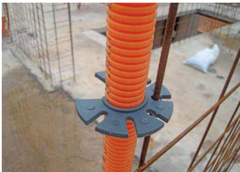
Figura 9 – Ligação eletroduto/armadura com utilização de espaçador plástico
