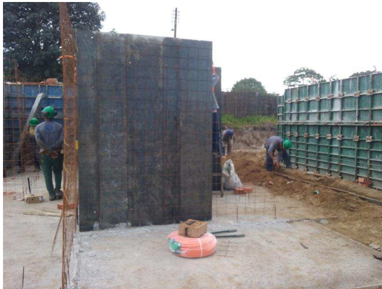
Figura 27 - Execução da armadura
