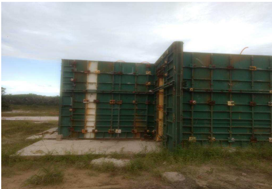
Figura 33 - Exemplo e posicionamento das fôrmas
