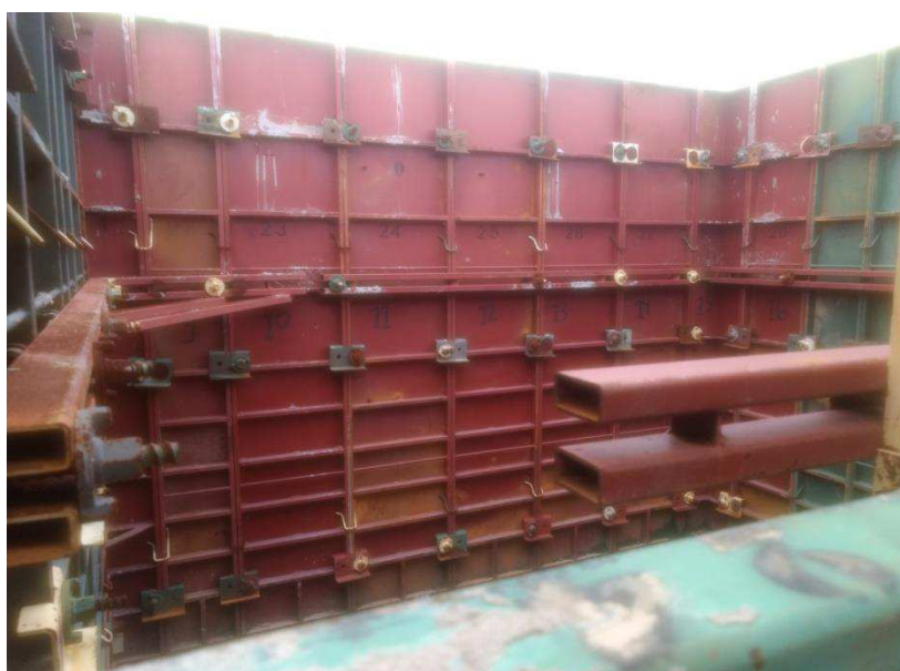
Figura 31 - Exemplo de posicionamento das fôrmas
