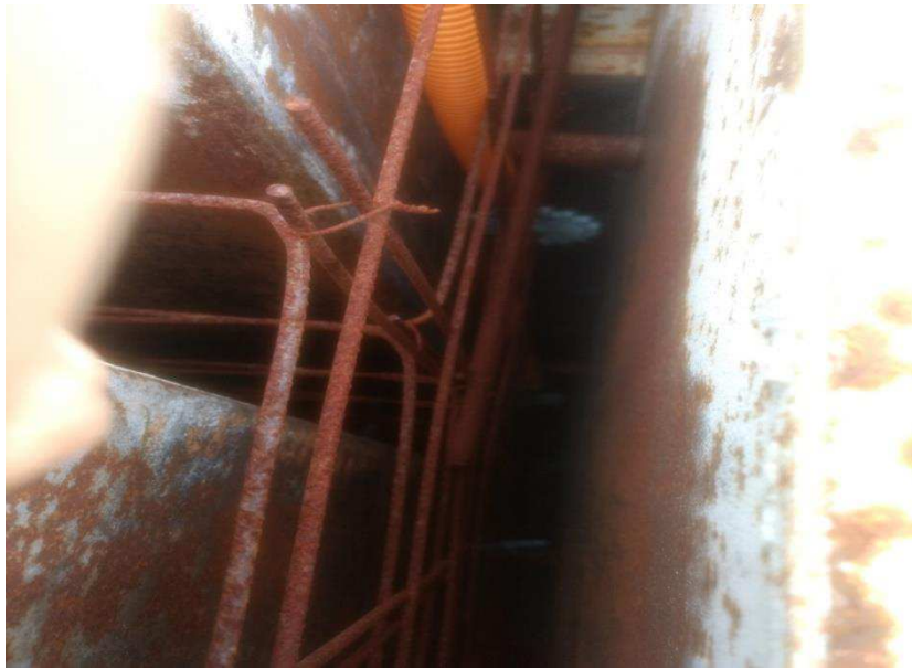
Figura 32 - Exemplo de posicionamento da armadura e fôrmas
