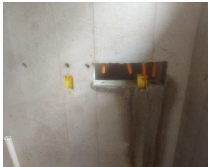
Figura 36 - Instalações embutidas após concretagem
