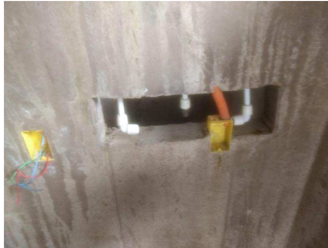
Figura 35 - Instalações embutidas após concretagem
