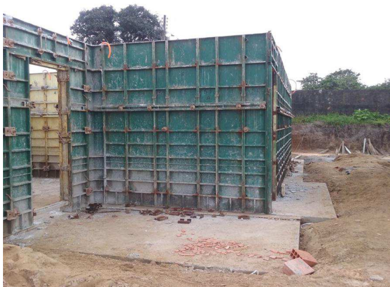
Figura 29 - Exemplo de posicionamento das formas
