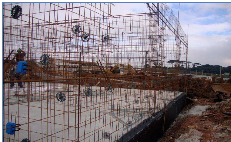
Figura 7 - Exemplo da execução de uma armadura
