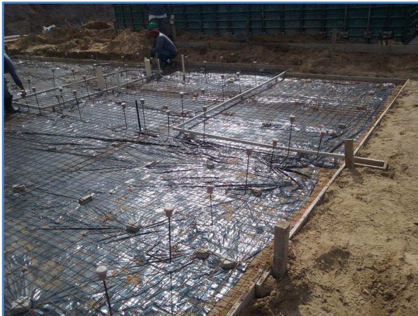
Figura 21- Preparação para recebimento do concreto
