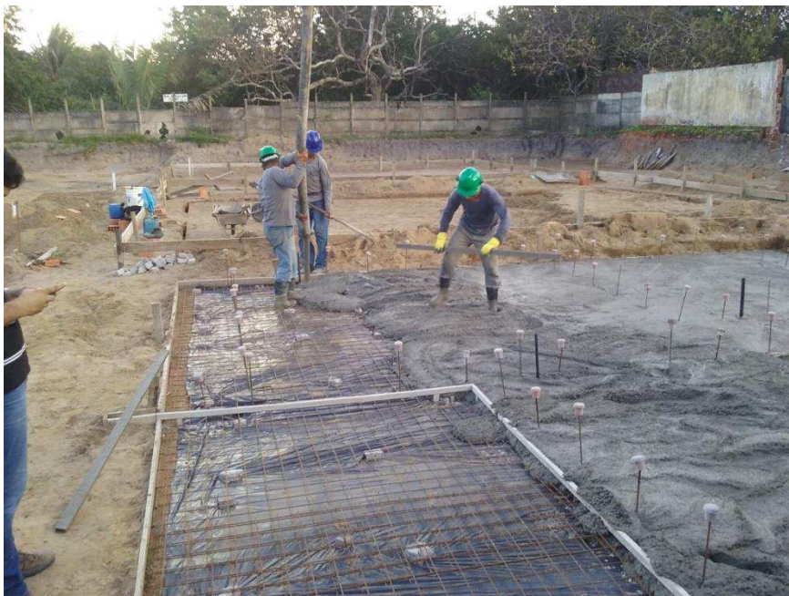
Figura 25 - Aplicação do concreto
