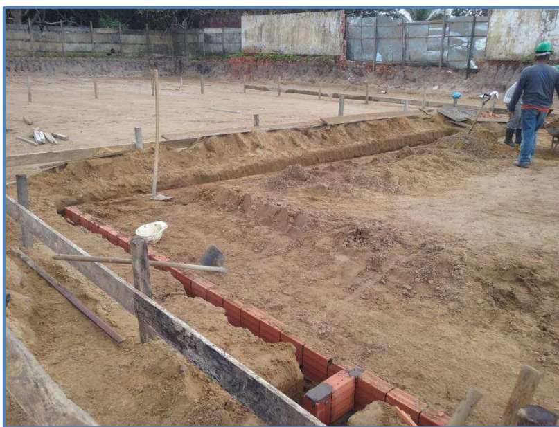
Figura 19 - Processo de execução da fundação
