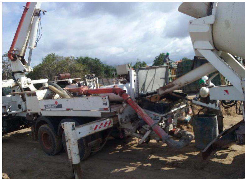
Figura 41 - Processo de lançamento do concreto
