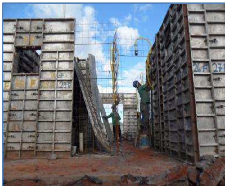
Figura 4 – Fôrmas de alumínio
