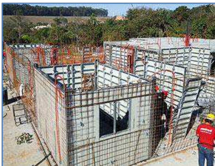
Figura 5 - Fôrmas de polipropileno
