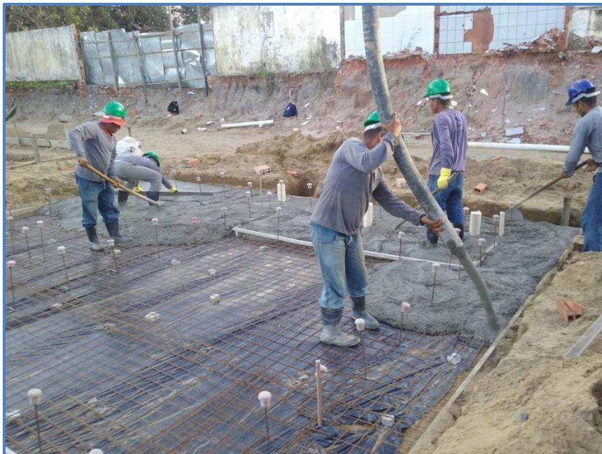
Figura 23 - Aplicação do concreto
