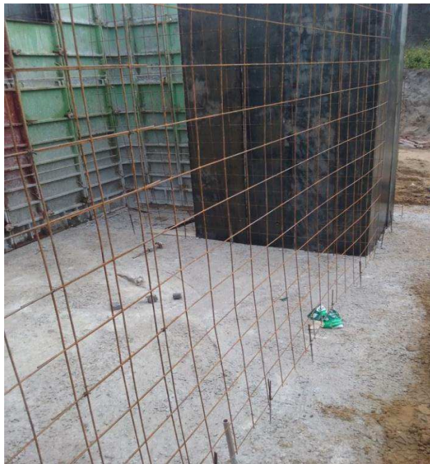
Figura 28 - Execução da armadura
