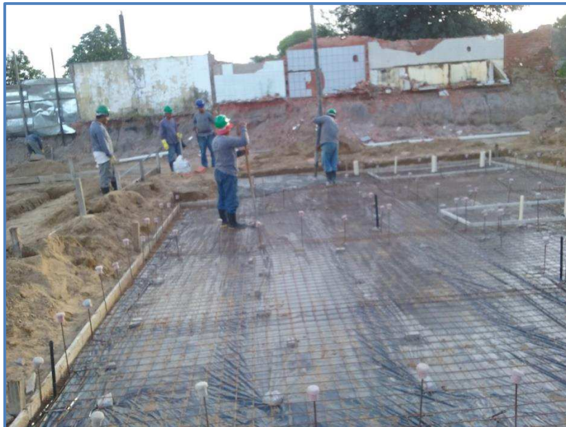
Figura 22 - Aplicação do concreto
