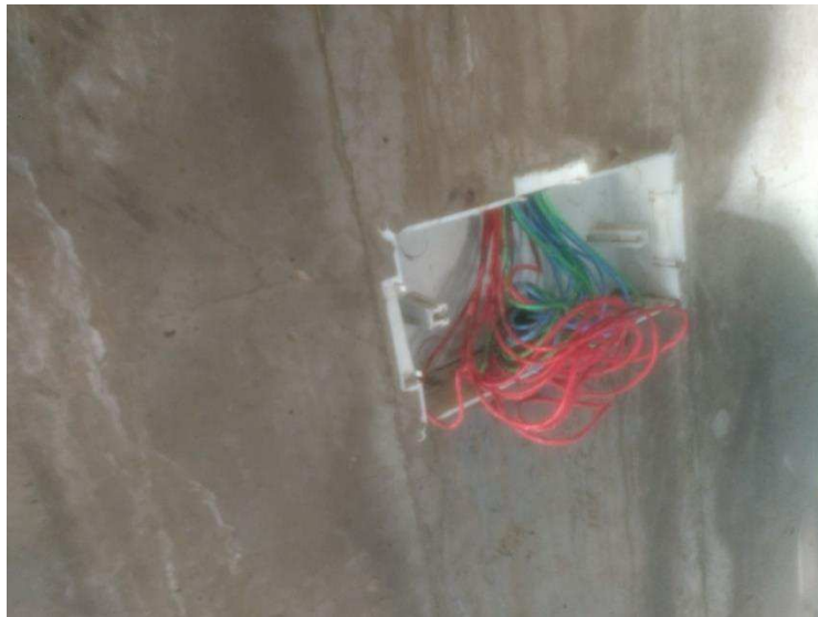
Figura 37 - Instalações embutidas após concretagem
