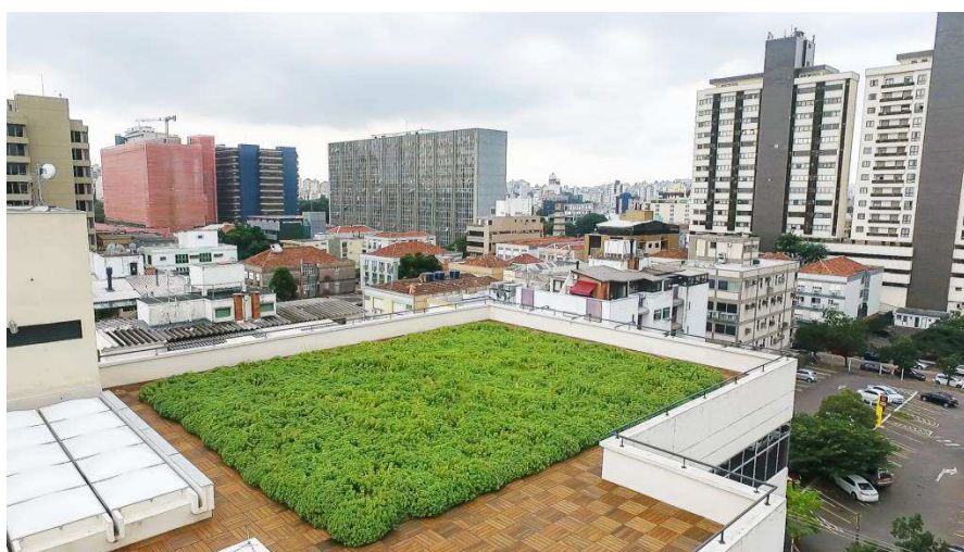
Figura 8 - Cobertura de edifício com telhado verde.
