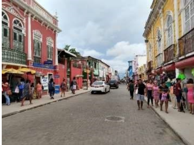
Figura 29 – Trecho da Rua do Passeio após as intervenções Fonte: Torres (2019)
