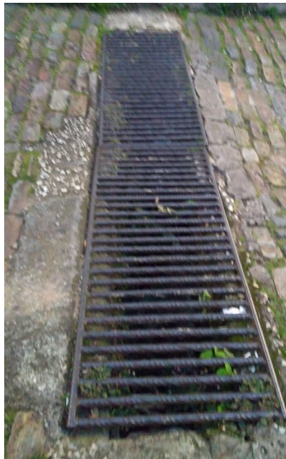
Figura 40 – Grelha para drenagem pluvial numa rua de Ouro Preto – MG Fonte: O Autor (2018)
