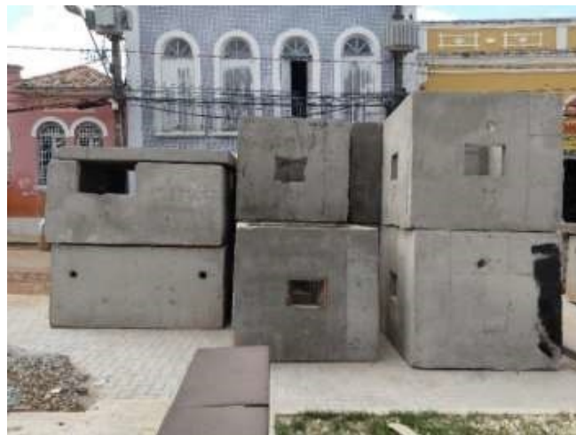
Figura 28 – Caixas de passagem para rede elétrica subterrânea Fonte: Torres (2019)
