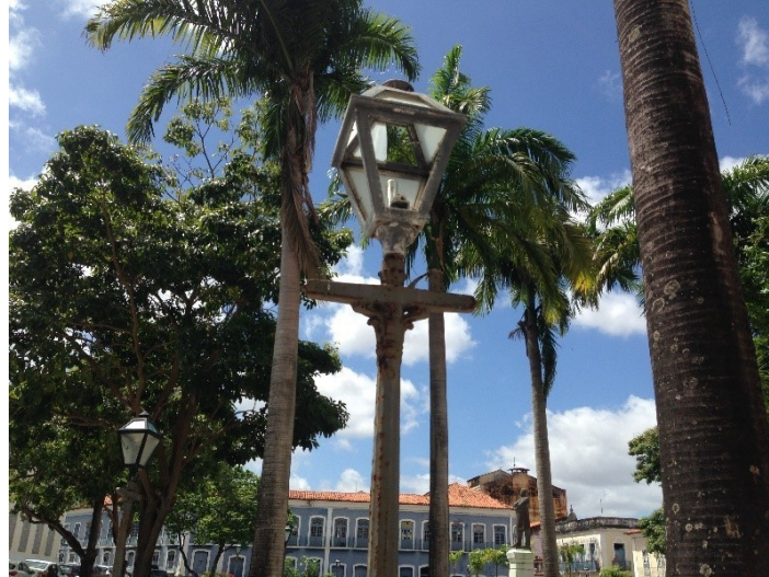
Figura 42 – Poste com fiação embutida no CHSL Fonte: O Autor (2018)
