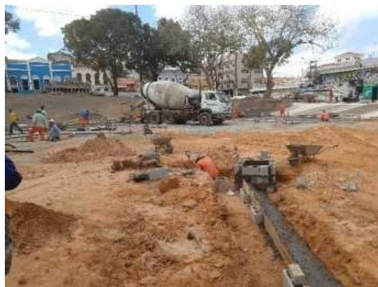
Figura 26 – Escavação para rede de drenagem profunda Fonte: Torres (2019)
