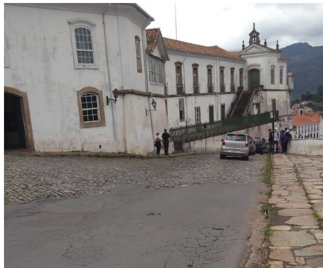
Figura 49 – Trecho de uma rua asfaltada em Ouro Preto – MG Fonte: O Autor (2018)
